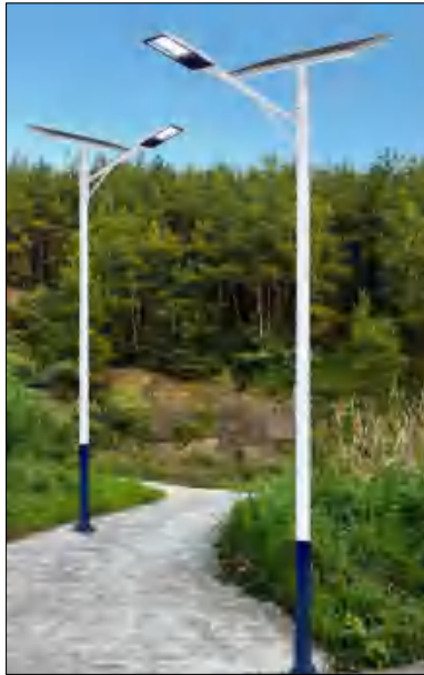
路灯 （成品采购及安装） 高度6m,60W，太阳能灯
