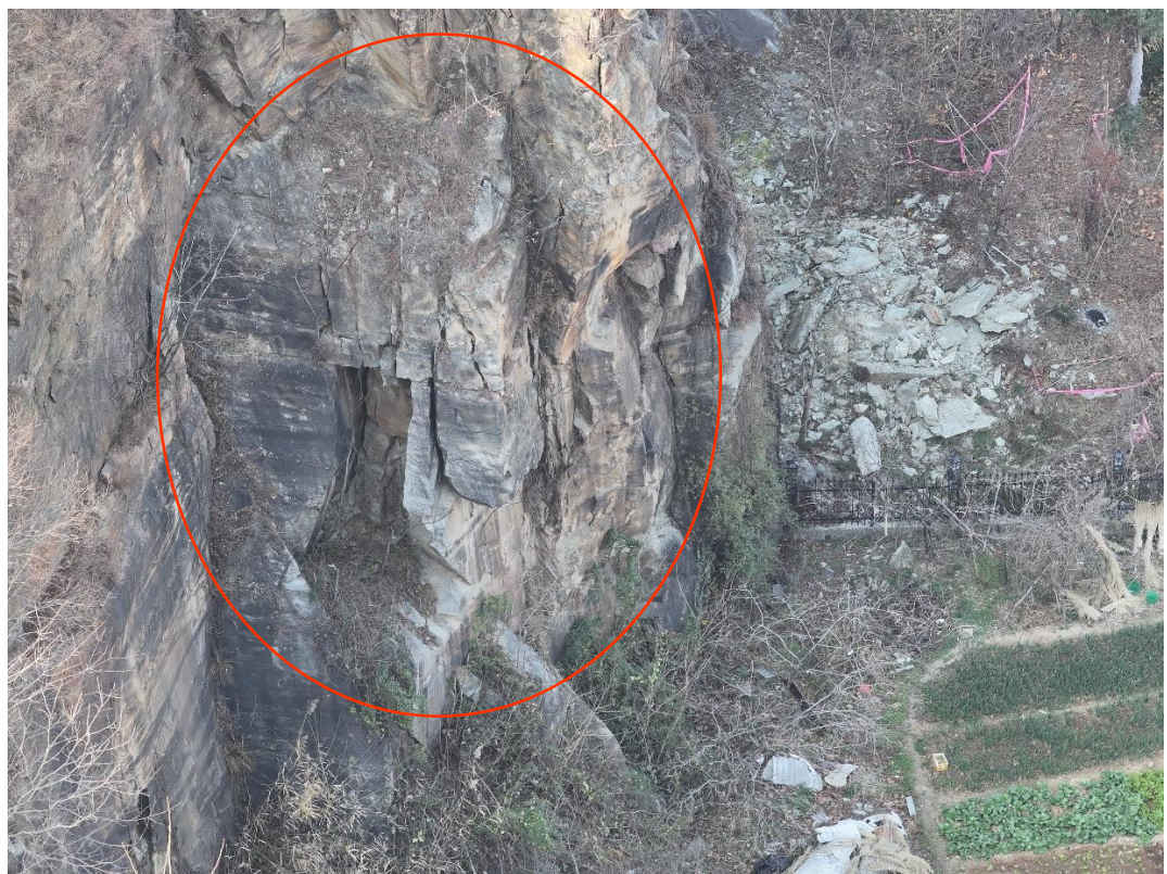
图 3-5 边坡坡面危岩体（自南东-北西方向）
