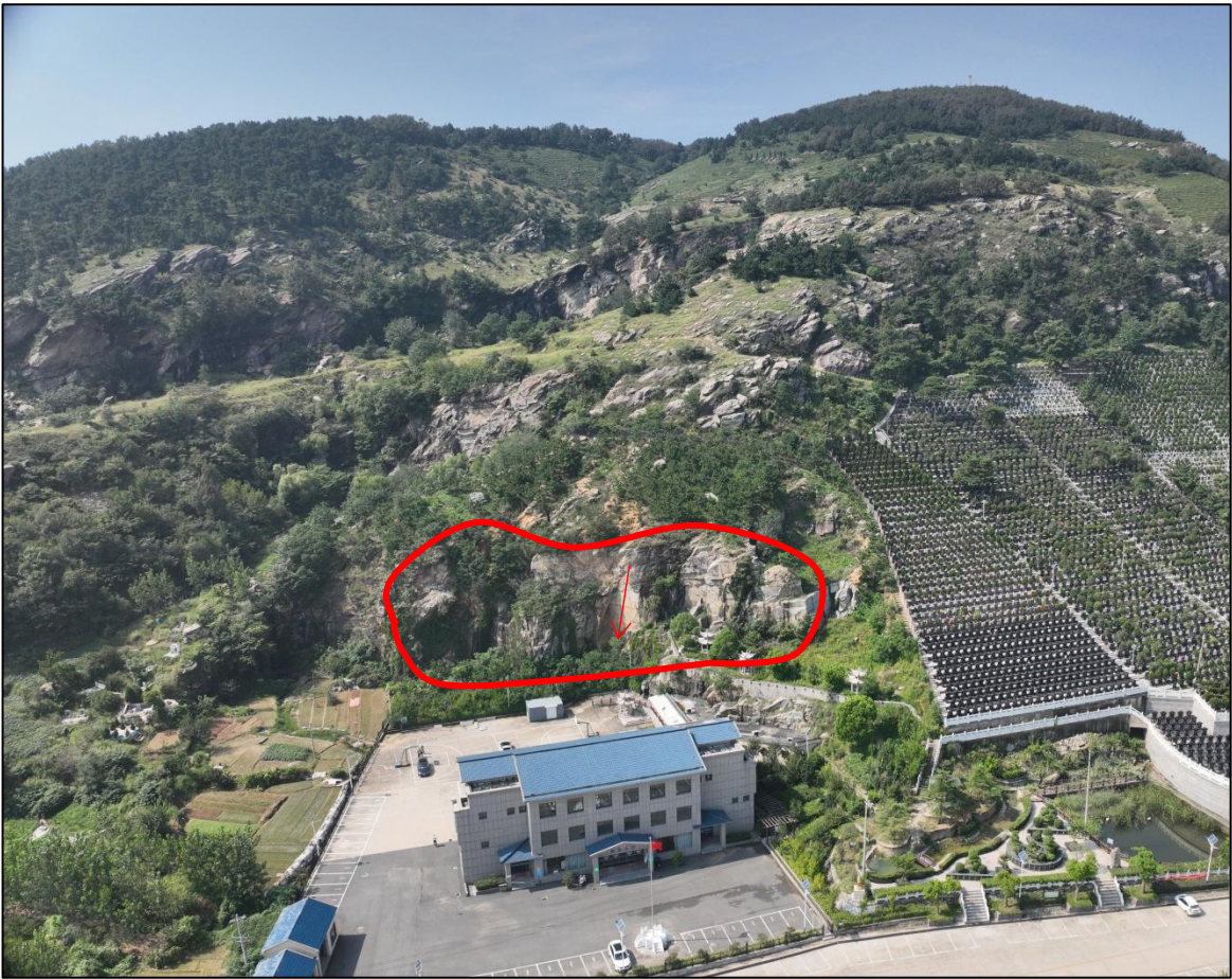
图 3-1. 石盘棋崩塌隐患点航拍（北东-南西向-）
