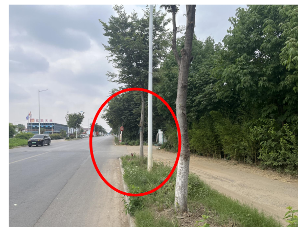
搭接道口缺少道口标柱
