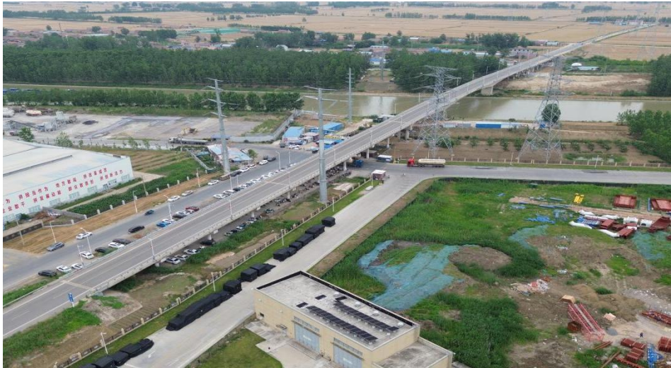
桥梁现状照片
