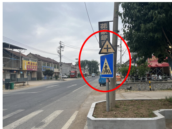
标志牌立柱高度不对且设置错误
