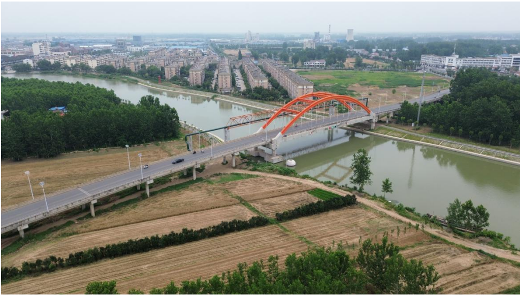
桥梁现状照片
