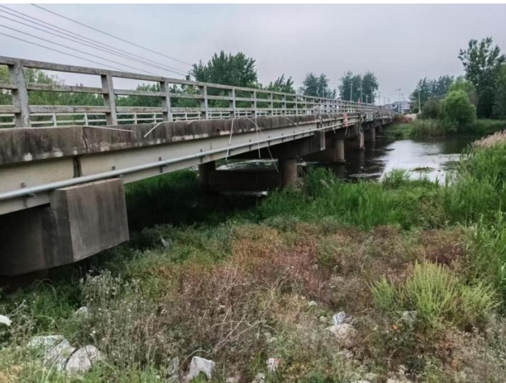
桥梁现状照片
