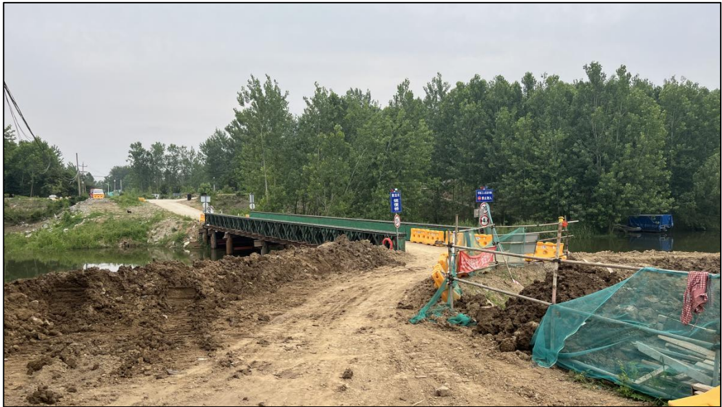
桥梁现状照片
