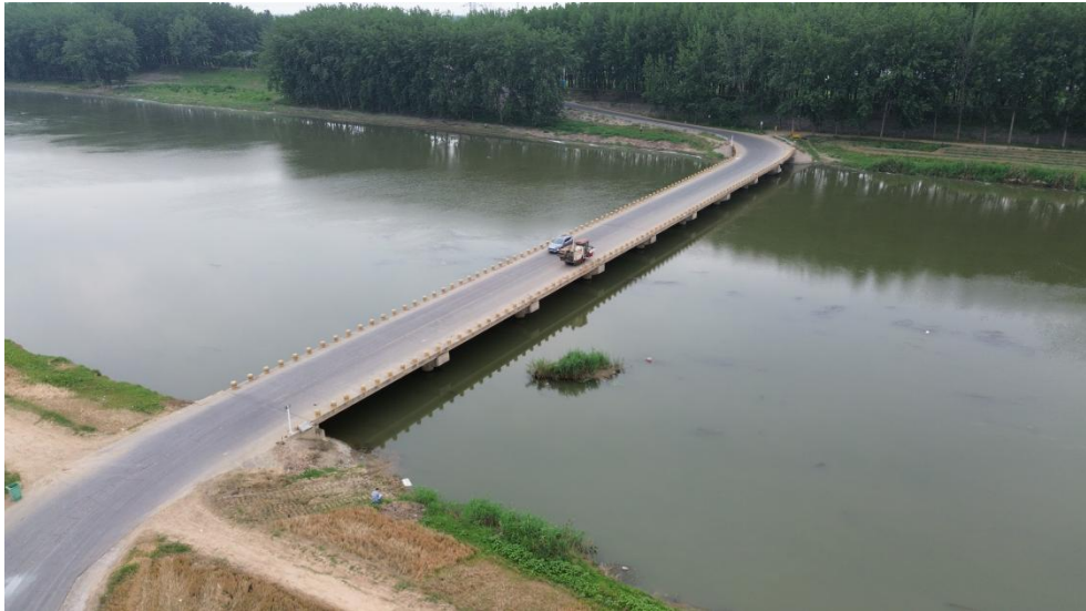
桥梁现状照片
