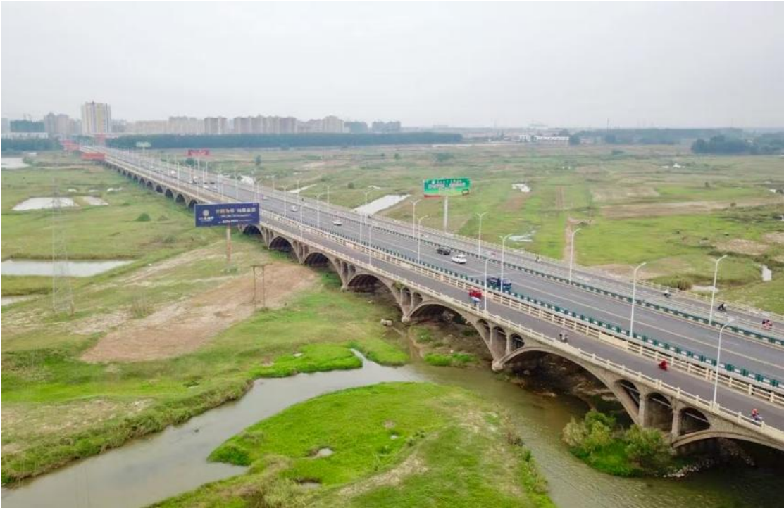
桥梁现状照片
