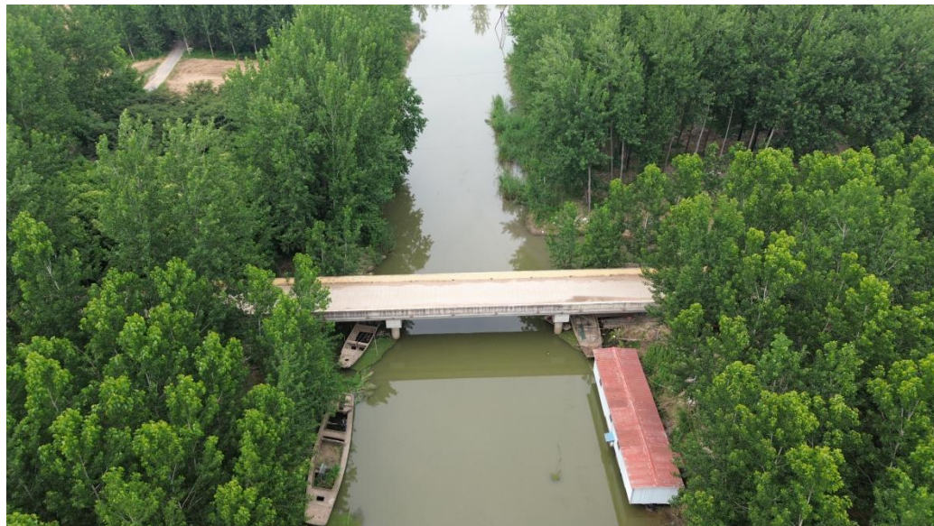
桥梁现状照片
