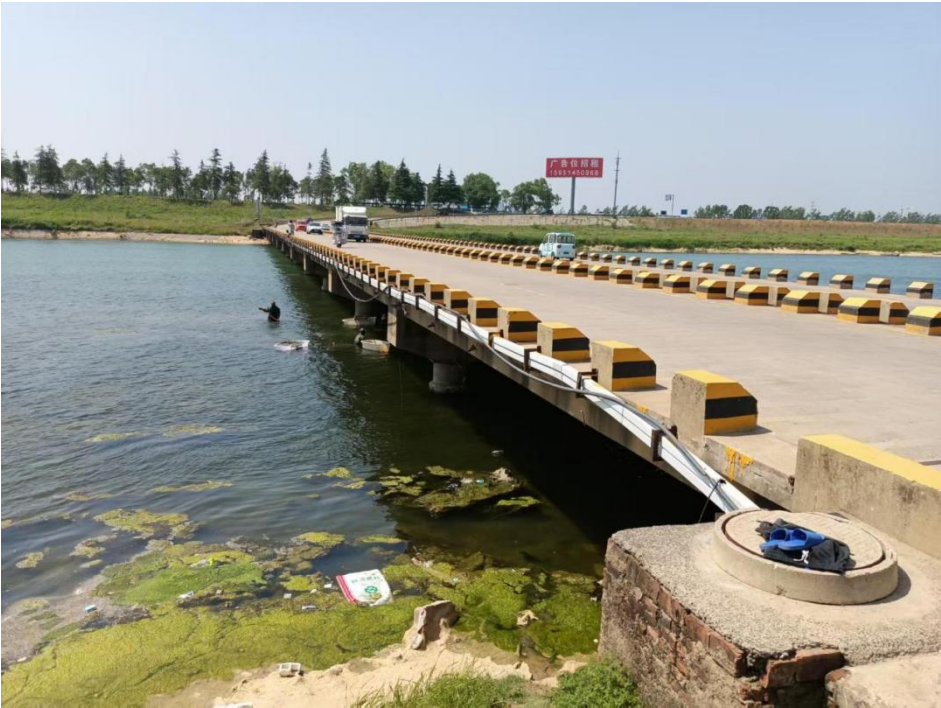
桥梁现状照片
