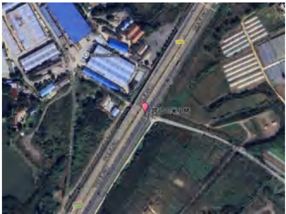
(c) 桥址位置
