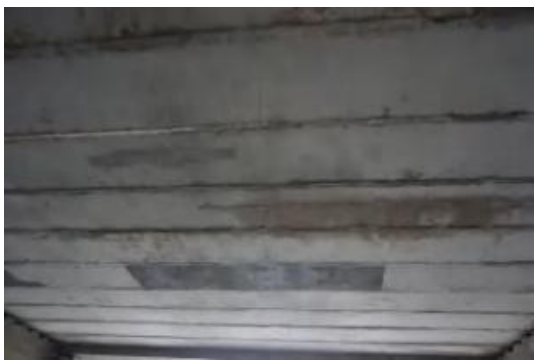
第 1 孔 1#底板超高车刮擦
