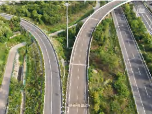
（a）道路封闭
