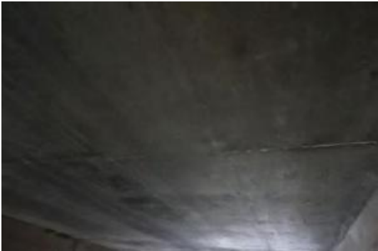
第 1 孔 1#底板超高车刮擦
