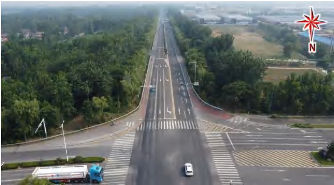
交叉口南入口现状
