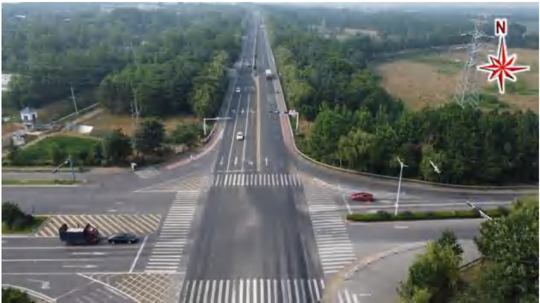
交叉口北入口现状
