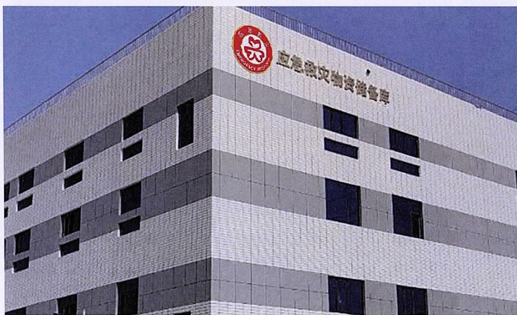
图 5 各级应急物资储备库悬挂标识示例
