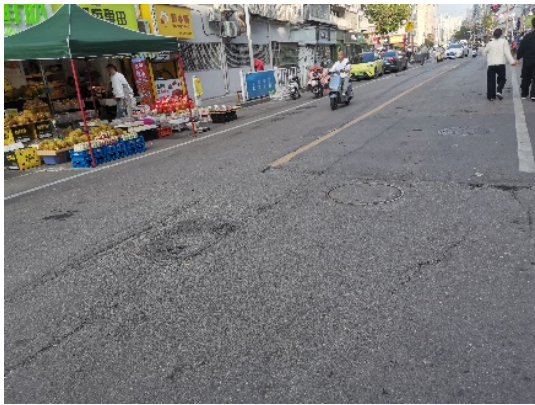
线裂、坑槽
