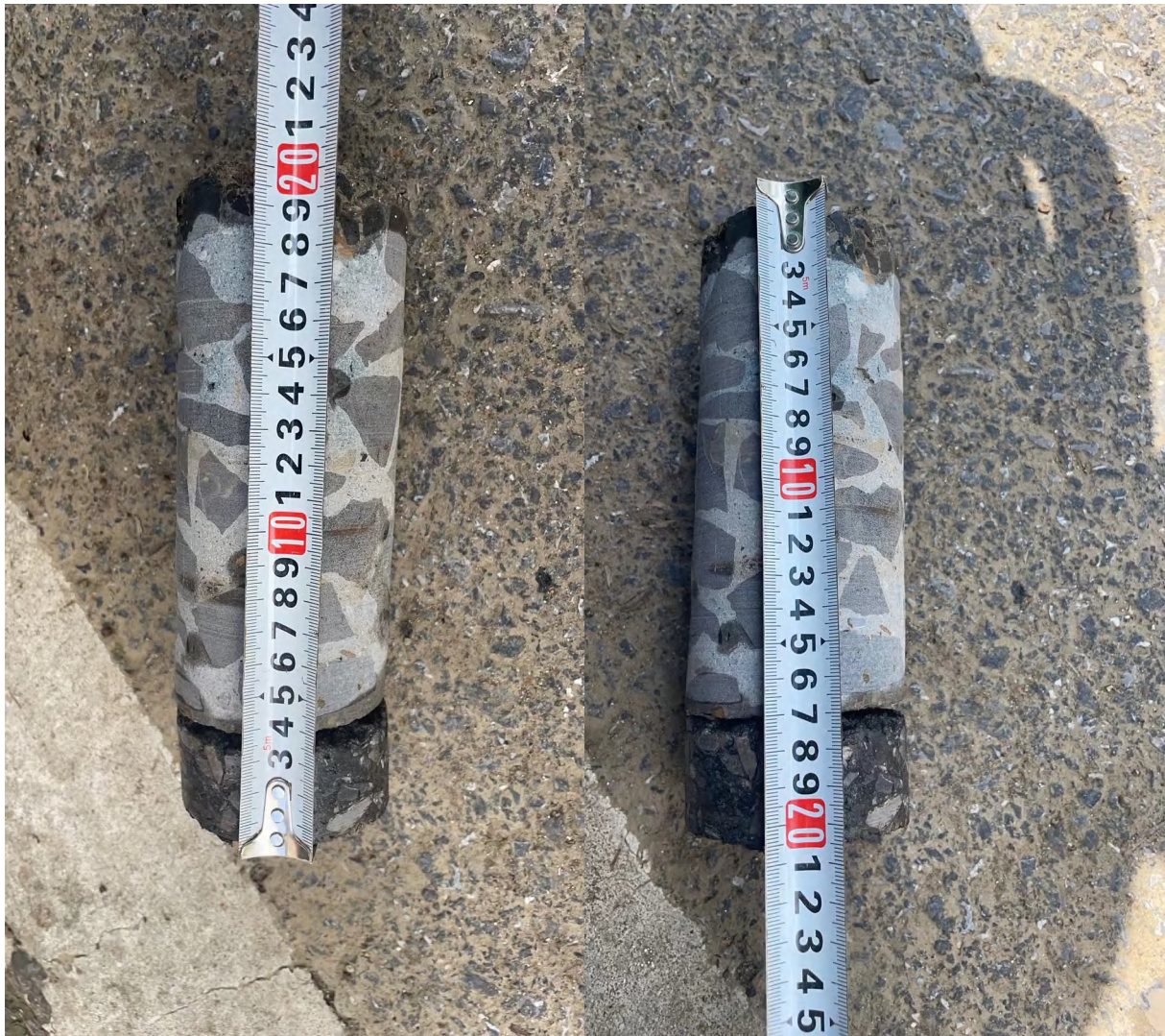
北杨线 1（取芯完整，基层混凝土厚度约 15cm，面层沥青约 4cm）
