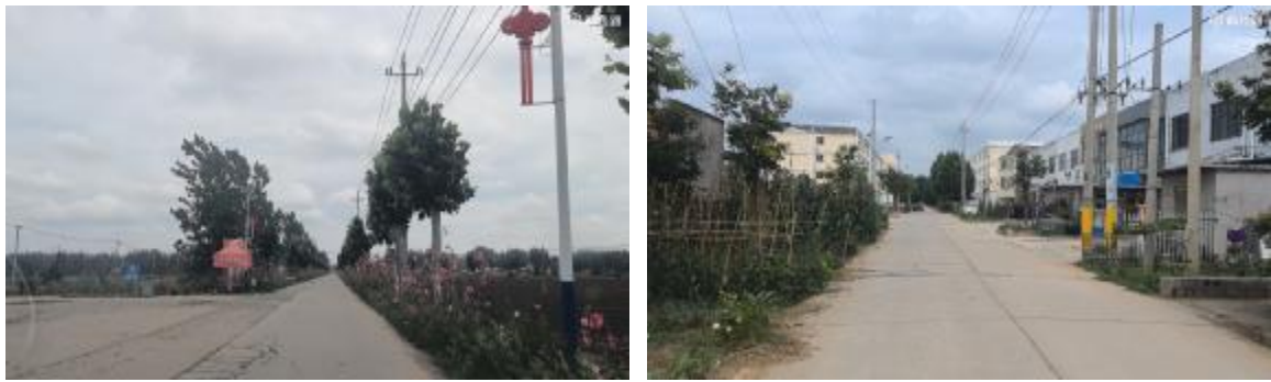
图 4-2 现状道路路基防护
