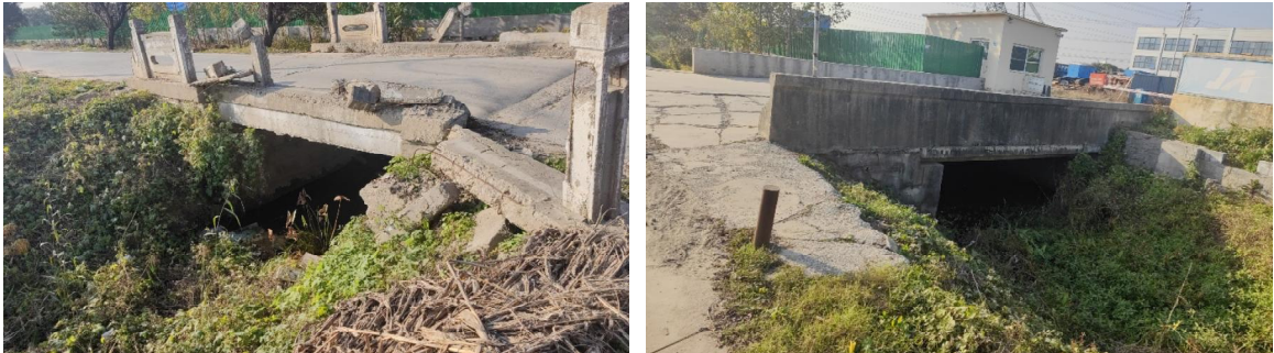
图 3-4 道路桥涵现状
