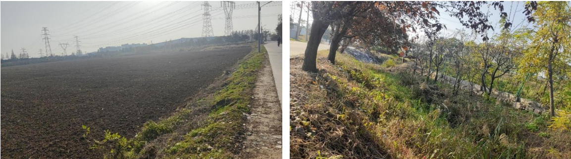
图 3-3 道路排水现状
