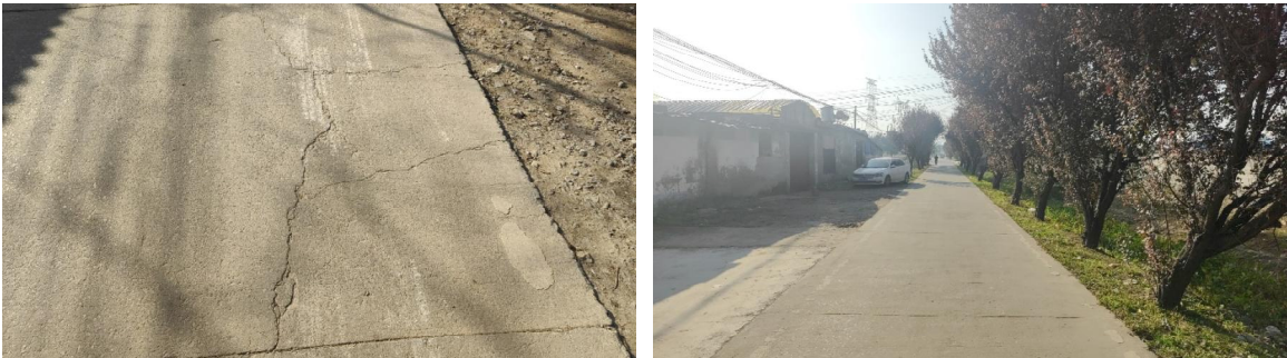
图 3-2 3.5m 宽水泥路面现状
