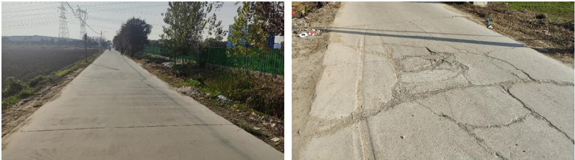
图 3-1 4.5m 宽水泥路面现状
