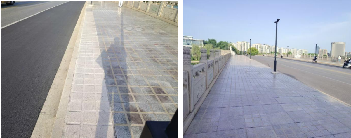
图 5.2-1 现状桥梁人行道铺装
