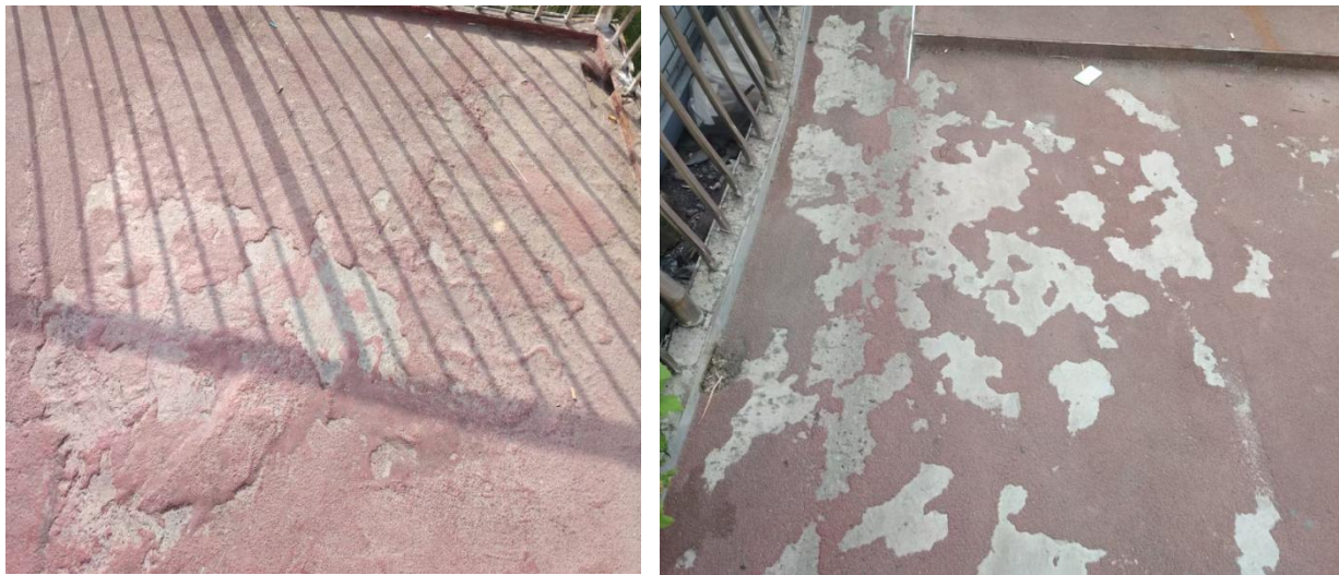
图 2.2-1 现状桥面铺装
