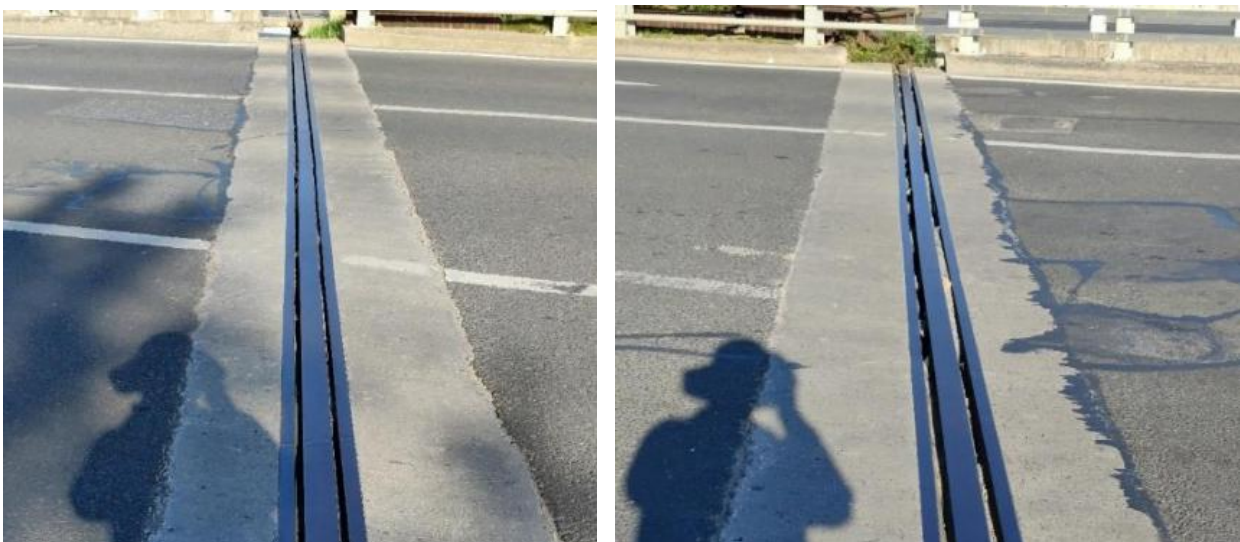
图 2.3-5 橡胶条破损
