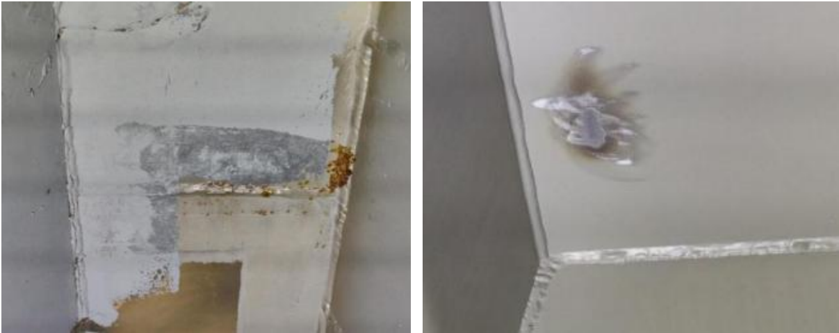
图 5.2-12 钢箱梁锈蚀
