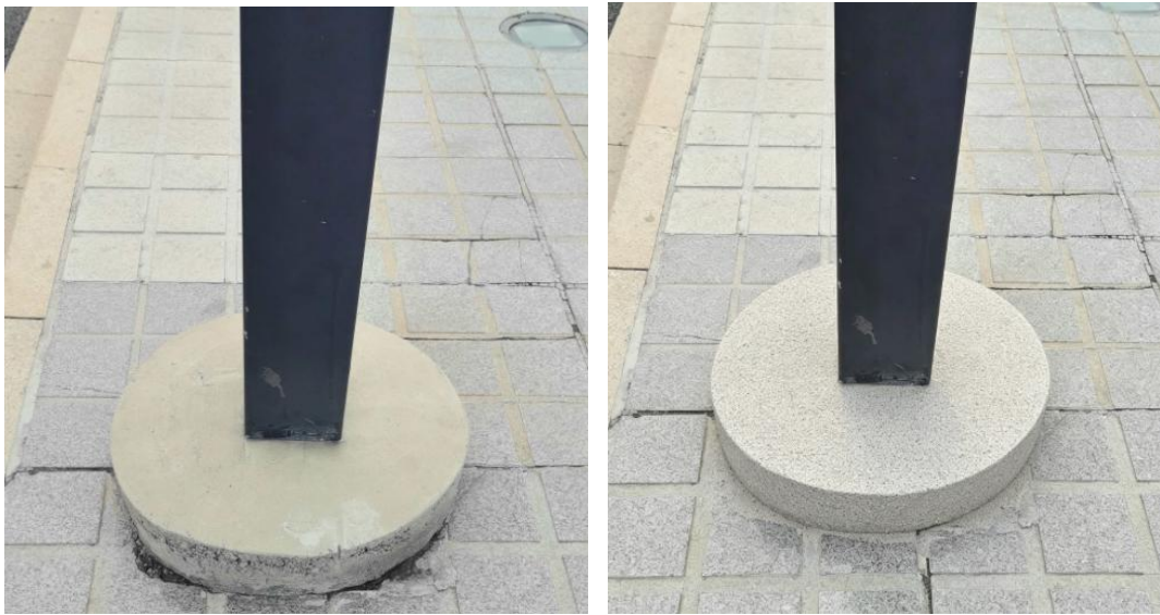
图 5.2-2 灯杆基础喷涂真石漆前后对比
