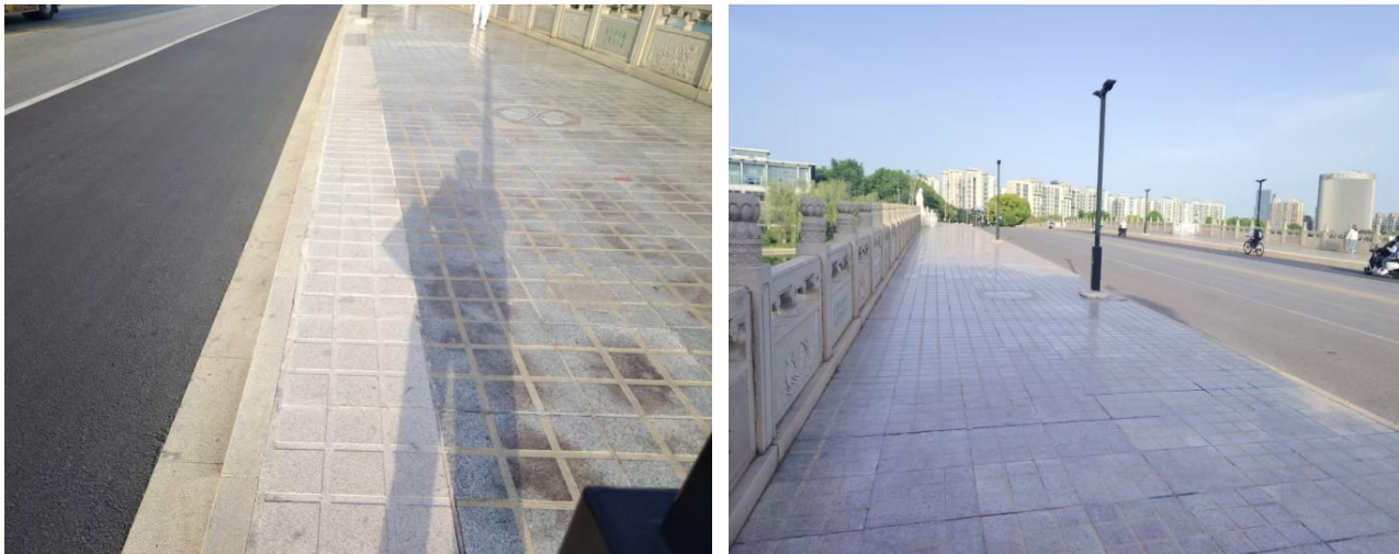
图 2.1-1 现状桥梁人行道铺装
