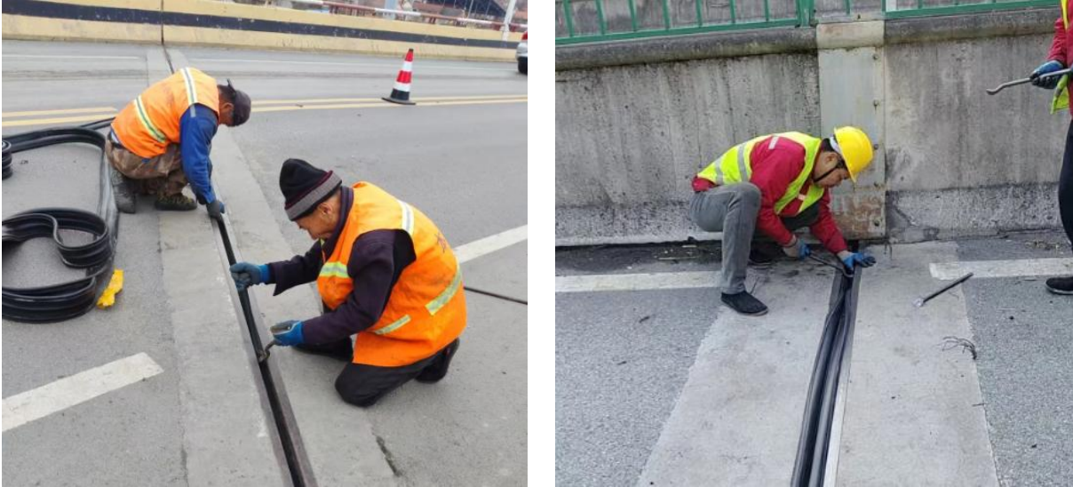
图 5.2-17 更换伸缩缝橡胶条
