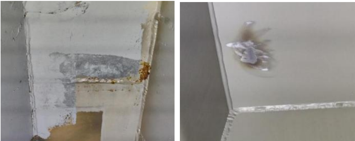
图 2.3-2 钢箱梁锈蚀
