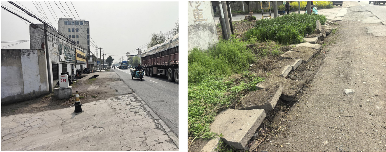
现状杆线、排水沟情况
