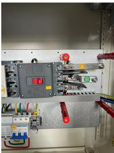
输入电缆 U、V、W 三相线接线示意图 4、
