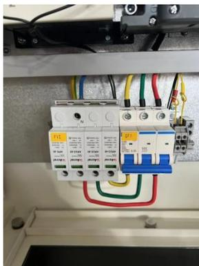
图 5-8 检查浪涌保护器及线路的老化、磨损情况
