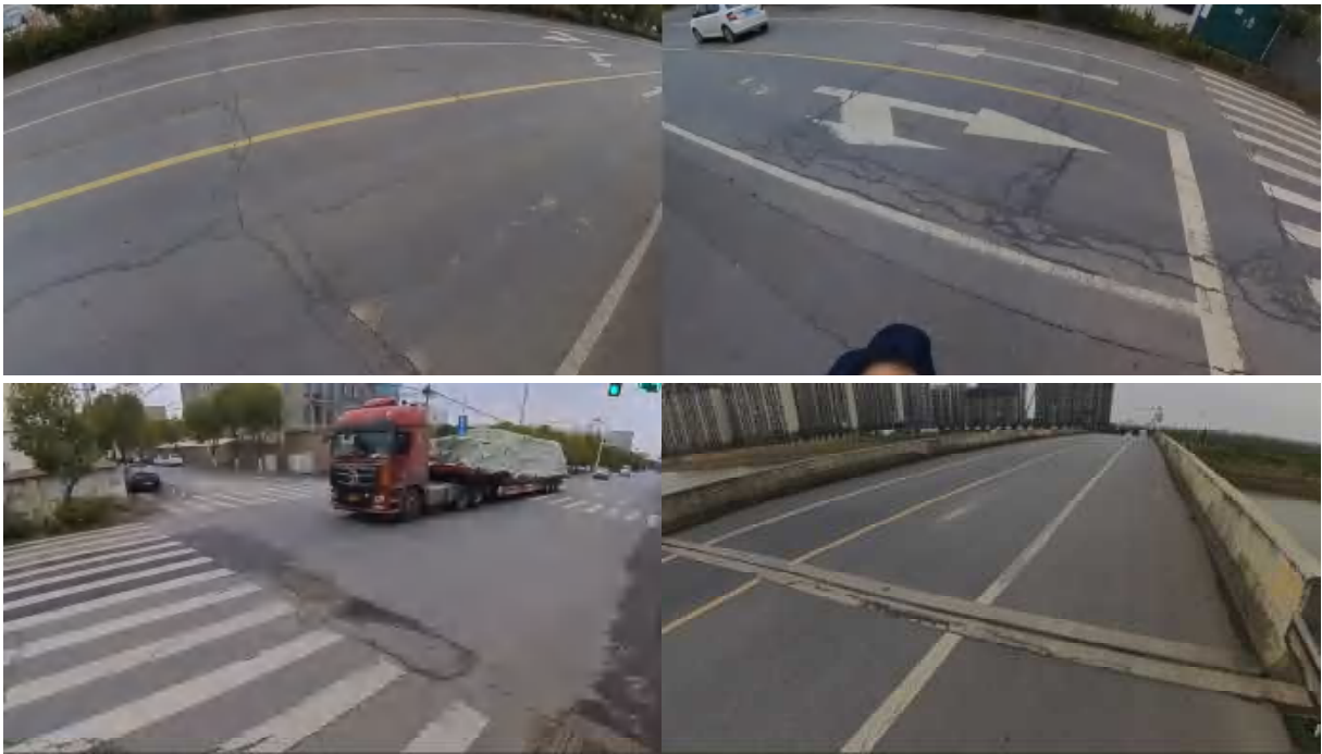
横向裂缝、纵向裂缝、修补、桥梁伸缩缝损坏
