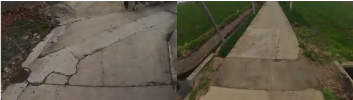
横向裂缝、纵向裂缝、板角断裂
