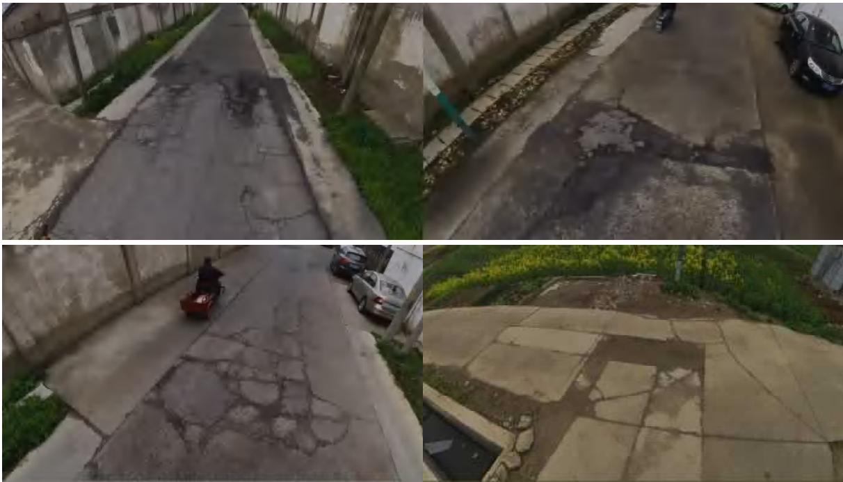
横向裂缝、纵向裂缝、板角断裂
