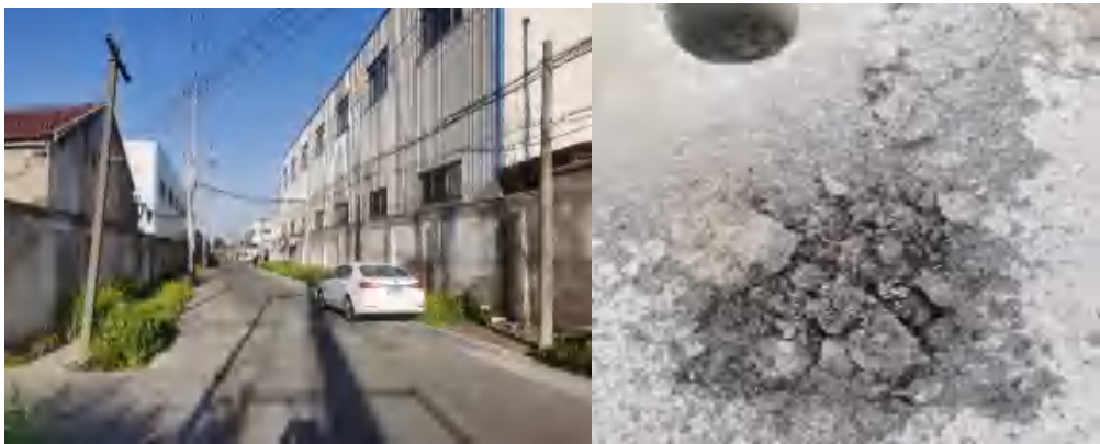
城东路起点沥青段 （取芯提不上来，全破碎，十公分以下有 2~3cm 沥青夹层，表层加铺层也损坏严重）
