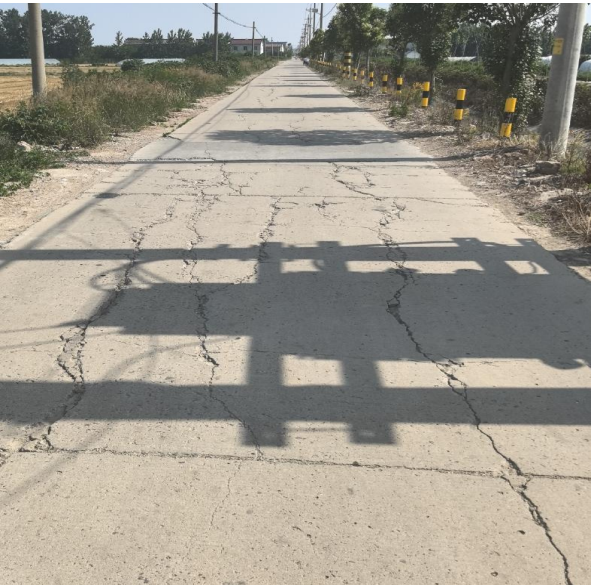
现状水泥混凝土路面
