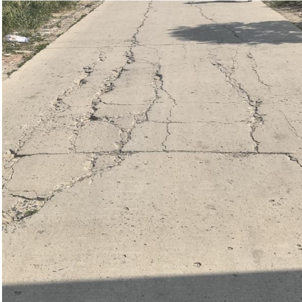
现状水泥混凝土路面
