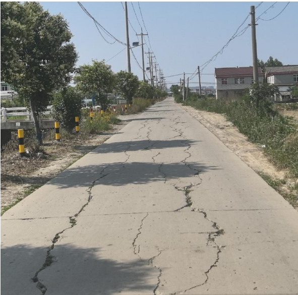
现状水泥混凝土路面
