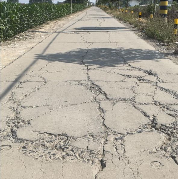
现状水泥混凝土路面
