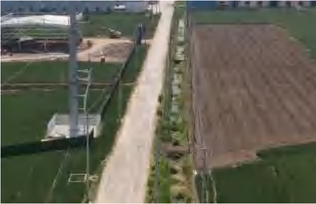
植树植草防护，散排、排涝沟排水
