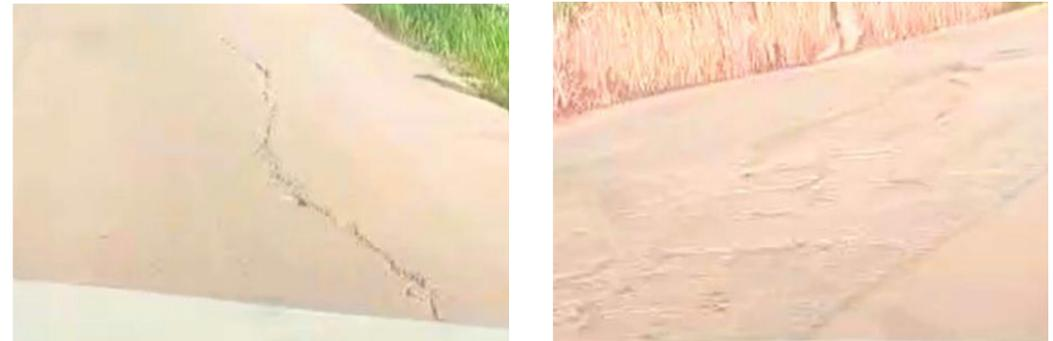
图 2-1 路面现状破损
