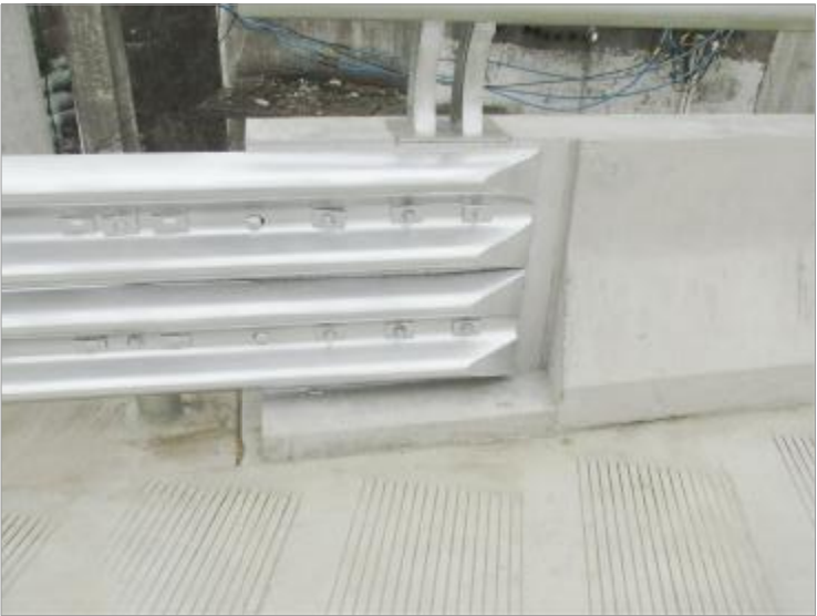
组合护栏端部槽口
