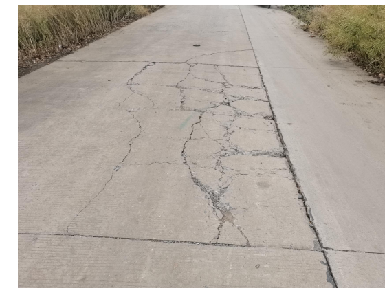
图 1-4 破碎板
