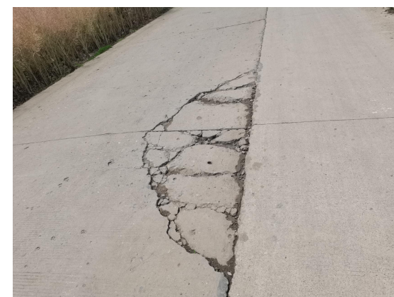
图 1-5 板角断裂
