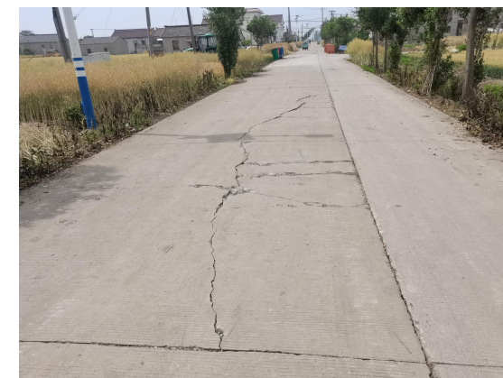
图 1-4 破碎板
