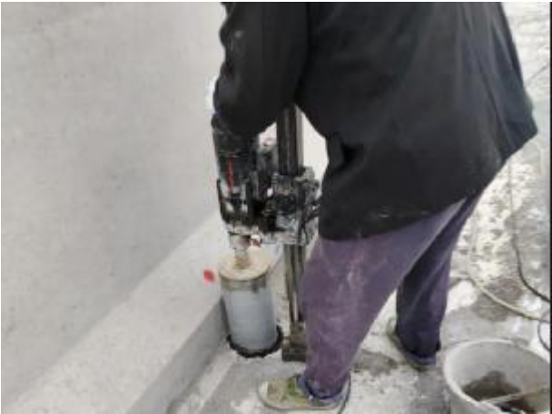
桥面水磨钻孔
