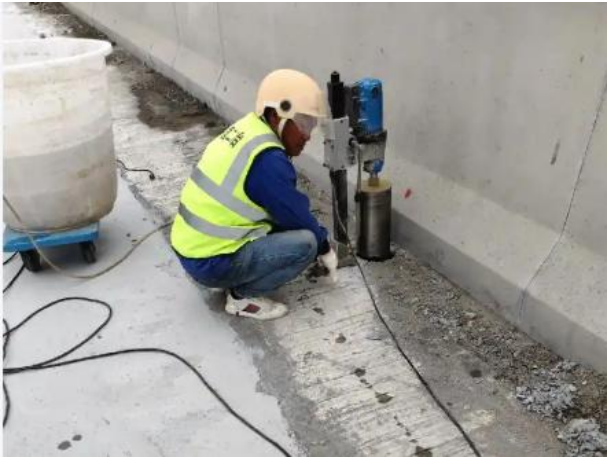
桥面水磨钻孔
