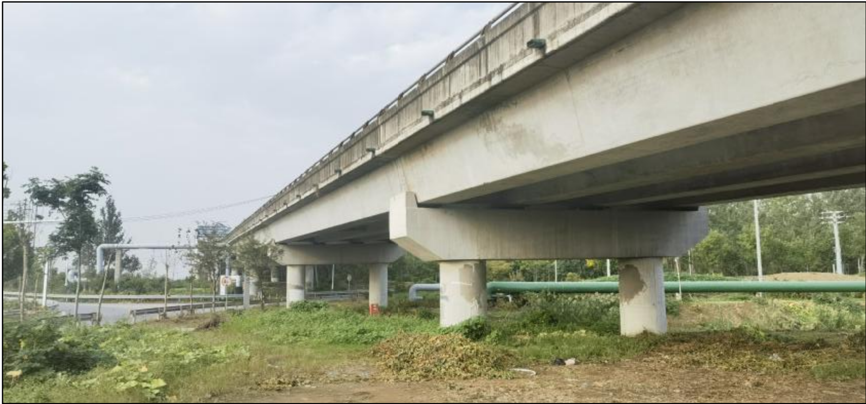
泄水管现状（现状老桥横向排水）
