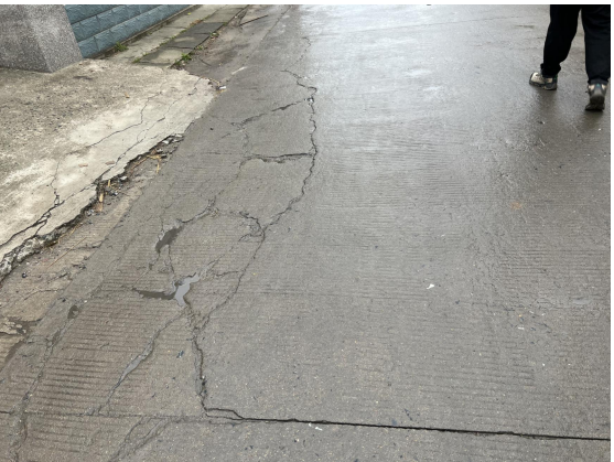
图 1-5 板角断裂
