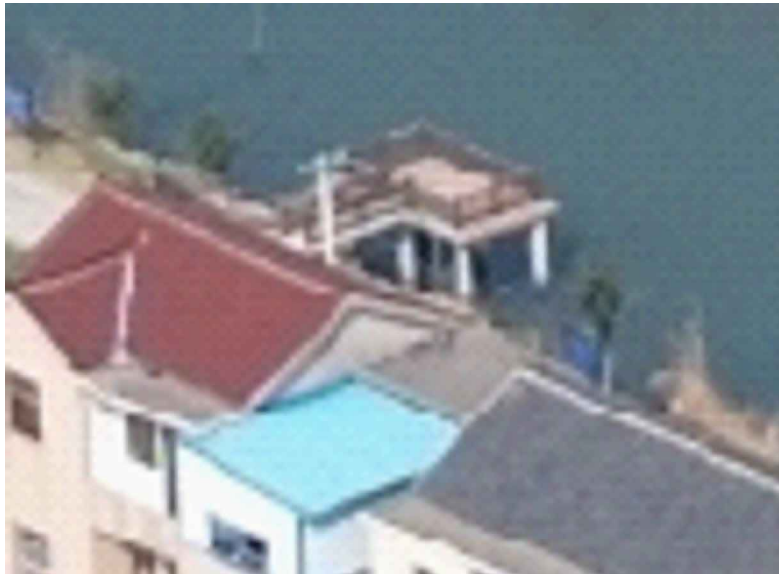
丁西组西侧亲水平台出新
