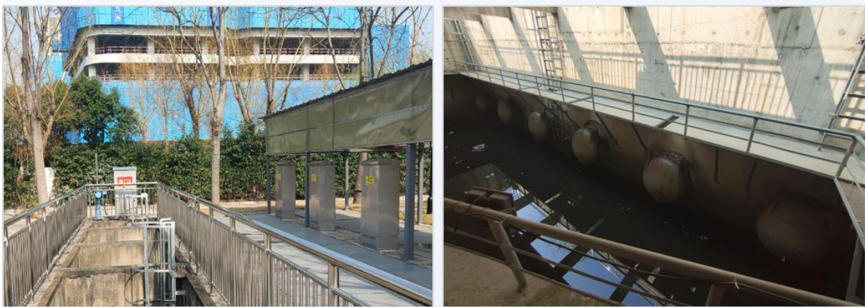
图 2.13 玉兰路蓄水池及泵站
