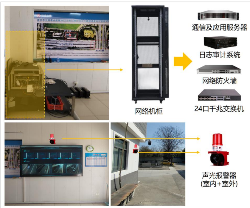
图 3.20 泵站指挥中心机设备布设示意图
