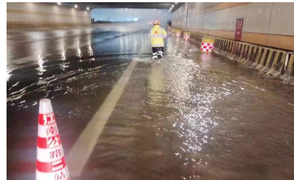
图 1.3 2023 年 7 月玉兰路隧道积水实景
