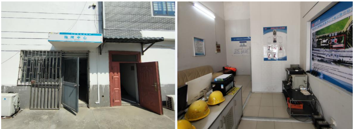
2.17 泵站指挥中心实景
