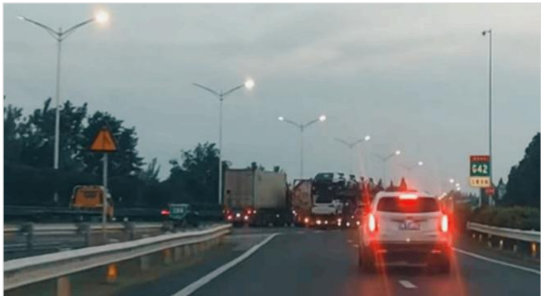
图 2.29 入口匝道合流点实景
