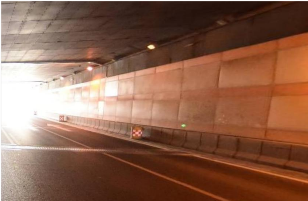
图 2.5 玉兰路隧道横向排水边沟实景 1（洞内）
