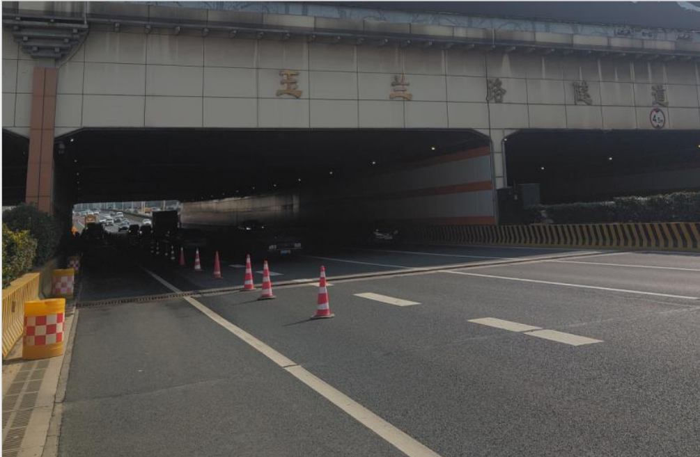
2.7 玉兰路隧道横向排水边沟实景 3（东侧洞口）
