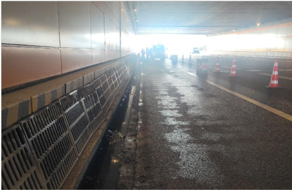
图 2.4 玉兰路隧道纵向排水边沟实景 2（西侧）
