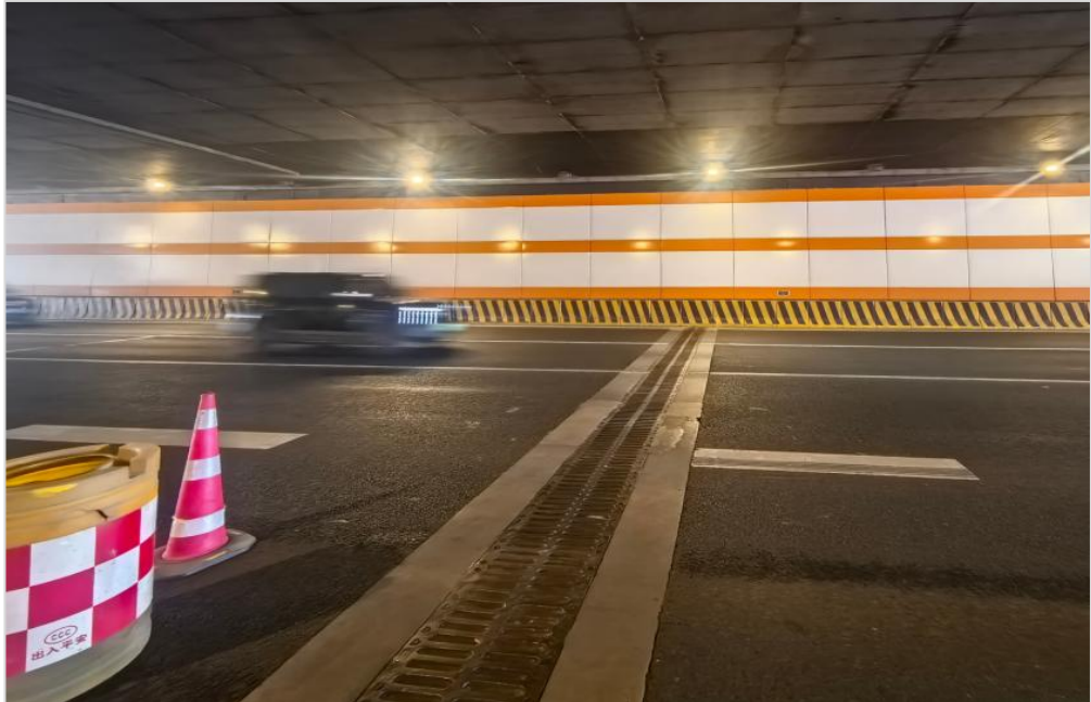
图 2.6 玉兰路隧道横向排水边沟实景 2（洞内）
