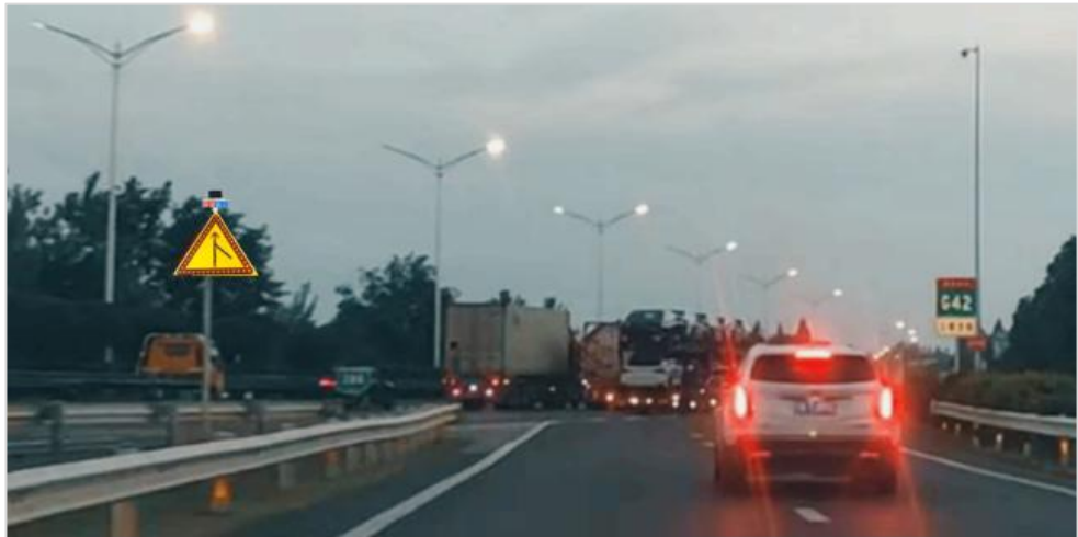
图 3.26 匝道与主线合流点发光标志提醒 (K287+970)
