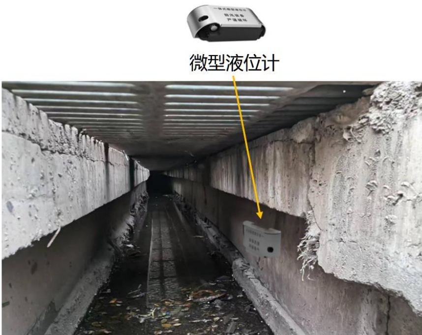
图 3.14 隧道边沟水位监测装置安装示意图
