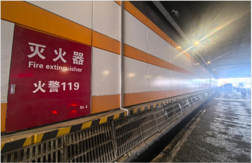
图 2.3 玉兰路隧道纵向排水边沟实景 1（东侧）
