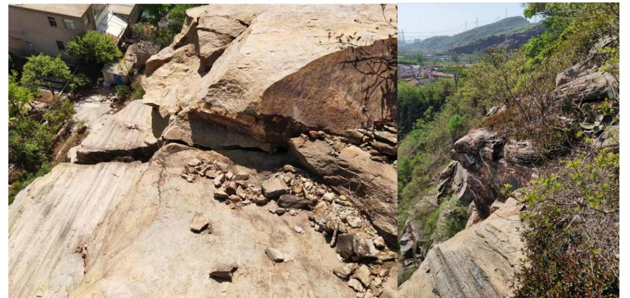
图 1-3、图 1-4 坡顶危岩体分布照片
