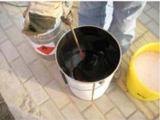
图 6 粘接剂拌合
