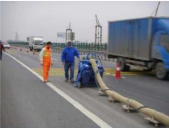
图 4 抛丸机精细打毛
