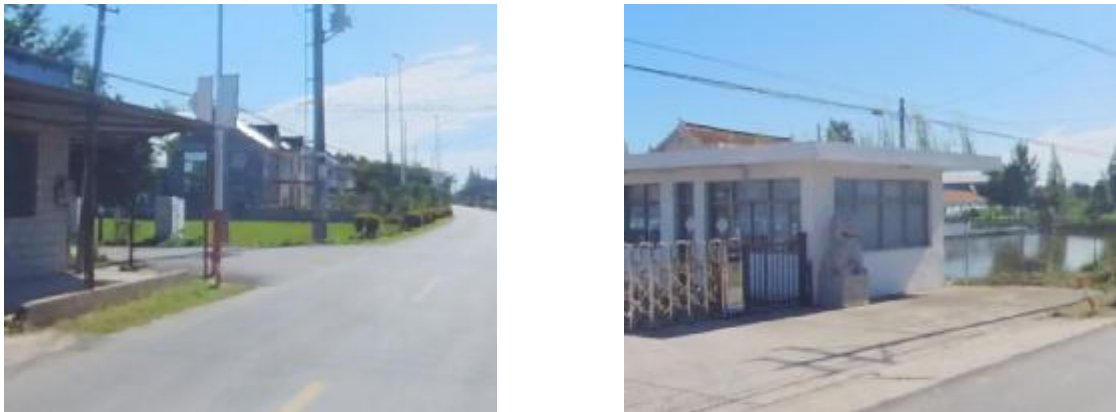
现状道口标柱
