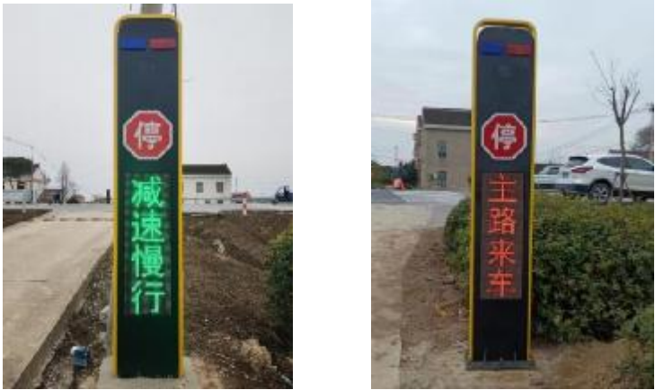
行人过街预警系统支路效果图（左：常规状态，右：预警状态） B 支路对主路的预警
