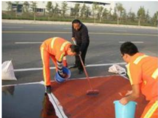
图 8 人工陶瓷骨料撒布
