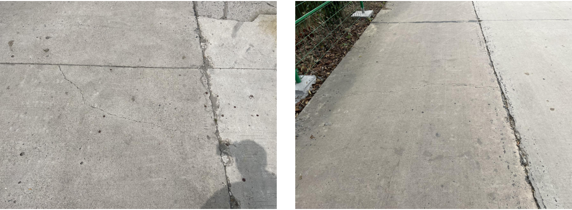
图 1-5 板角断裂
