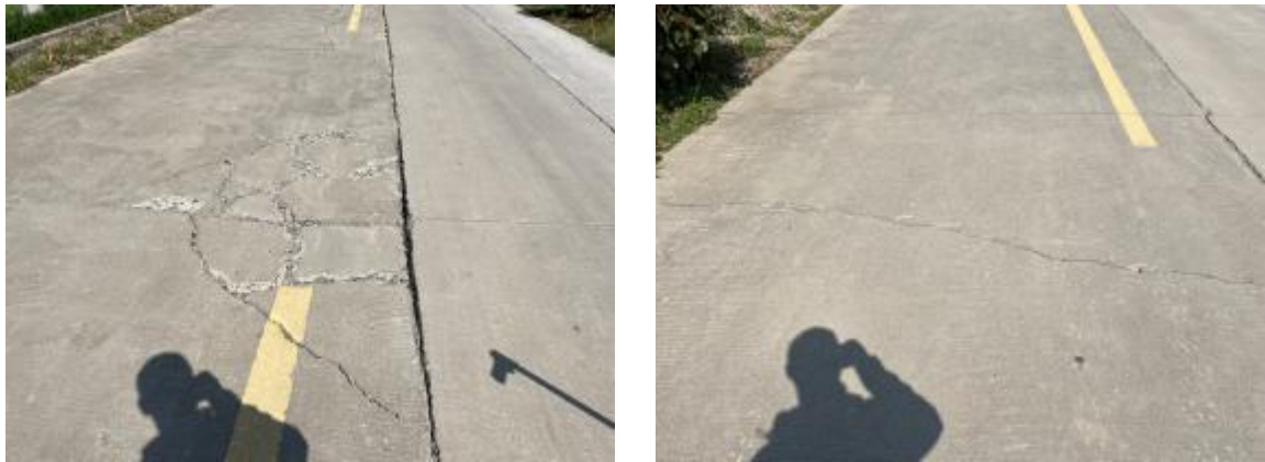
图 1-5 板角断裂
