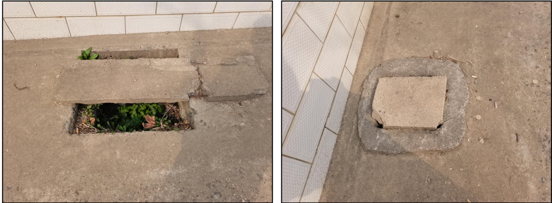
图2-5 路基、路面排水现状图
