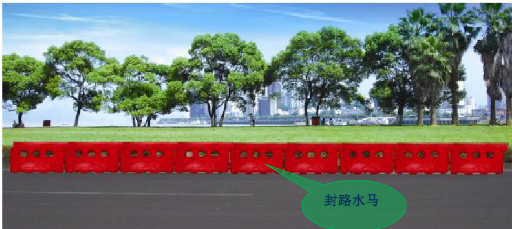
封闭施工所需围栏效果图
