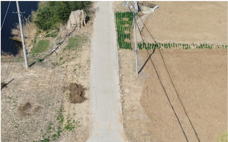
图 4-8 现场道路两侧防护及排水情况
