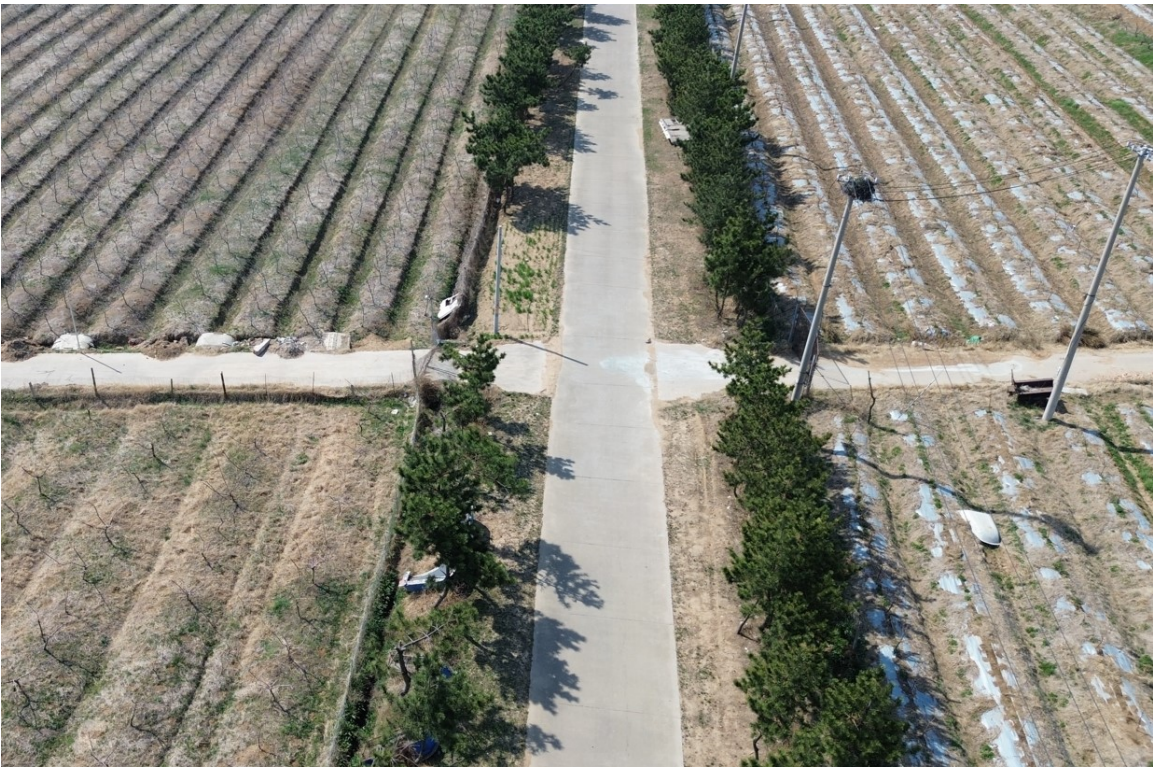
图 4-7 现状交安设施不完善
