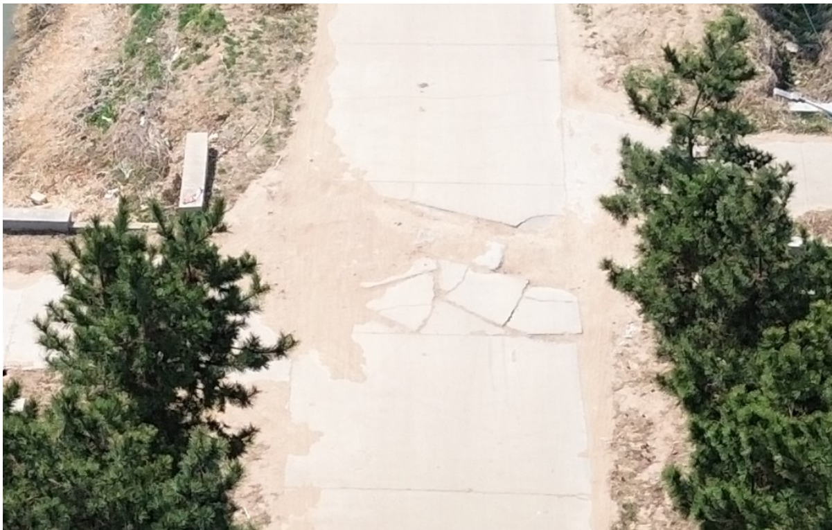
图 4-5 现状路面平整度调查图
