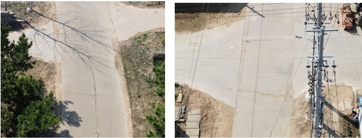
图 4-6 破碎板图
