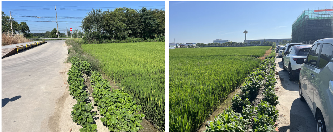
珩太路路基防护照片
