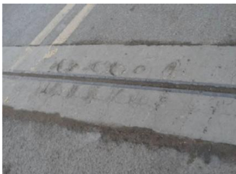
1#伸缩缝锚固区混凝土碎裂
