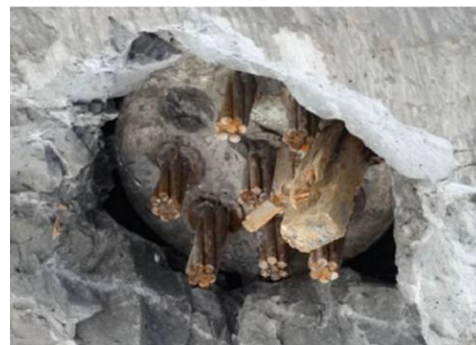
2-2-8#吊杆缺失 2 根钢绞线
