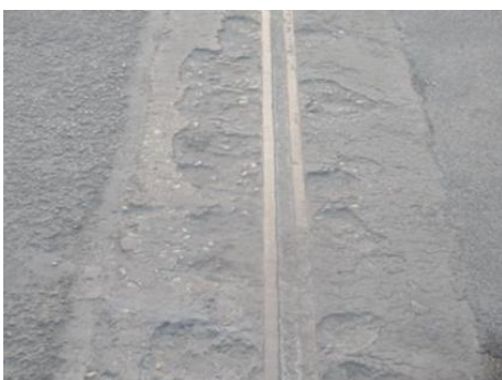
4#伸缩缝锚固区混凝土破损
