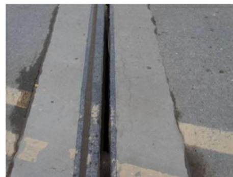
2#伸缩缝锚固区混凝土开裂
