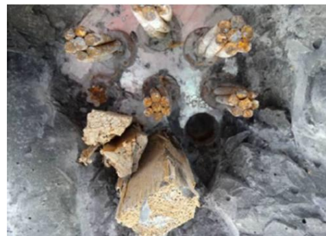
2-2-4#吊杆缺失 3 根钢绞线
