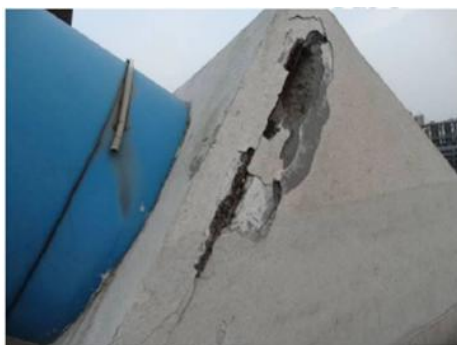
2-1#拱脚混凝土开裂破损
