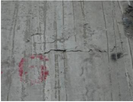
2-1#墩混凝土胀裂
