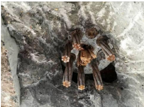
2-2-4#吊杆缺失 3 根钢绞线
