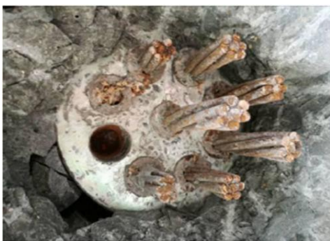
2-2-7#吊杆缺失 2 根钢绞线
