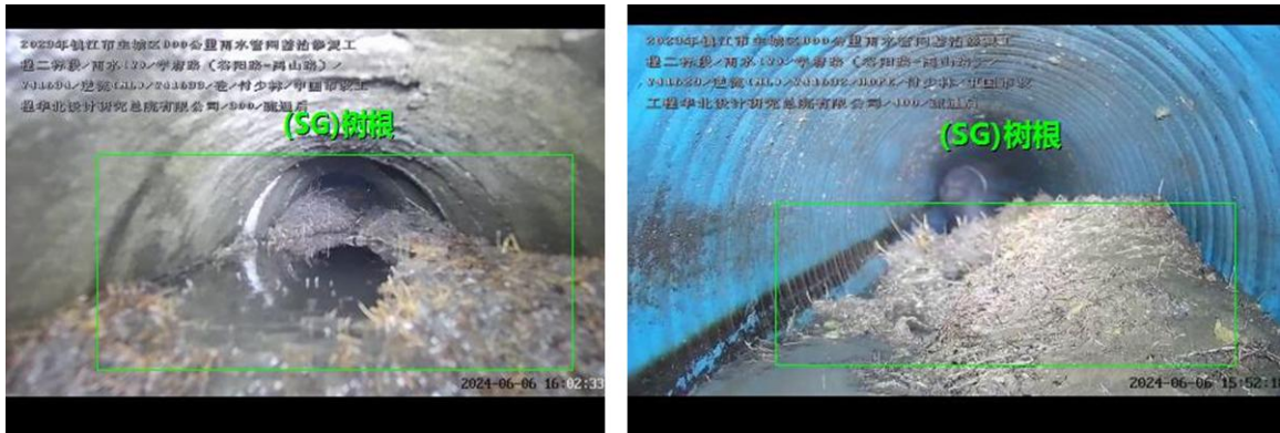
图 5-21 管道整疏通清理修复示例图
