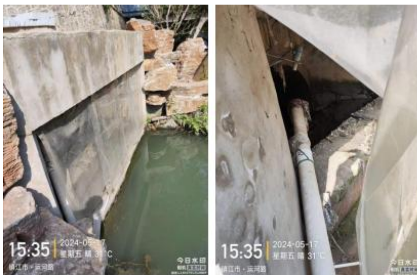
图 3-11 东排口现状情况图
