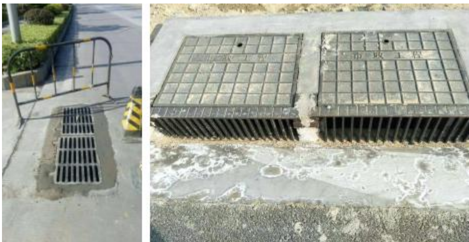
图 5-7 平箅式和立箅式雨水口
