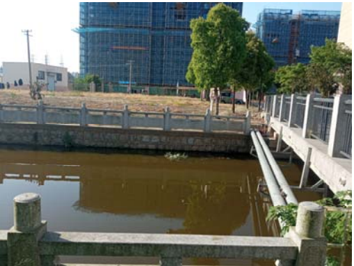
桥梁西侧电力管线
