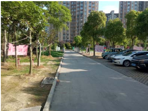
现状水泥路面
