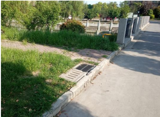
现状暗埋管+集水边沟
