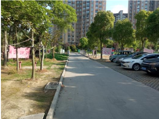
现状水泥路面
