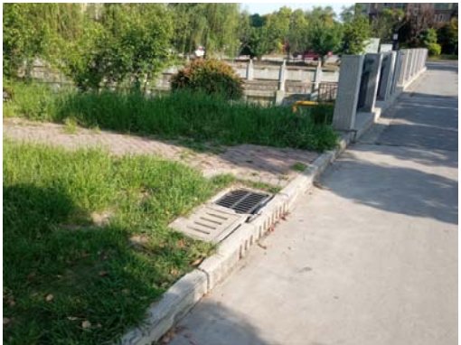
现状暗埋管+集水边沟
