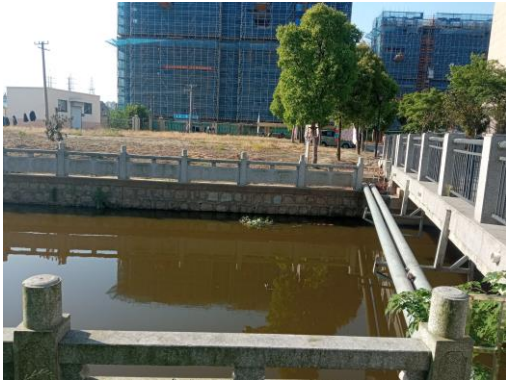
桥梁西侧电力管线
