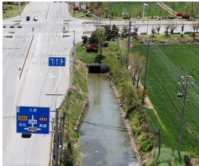
起点处 S33 现状箱涵
