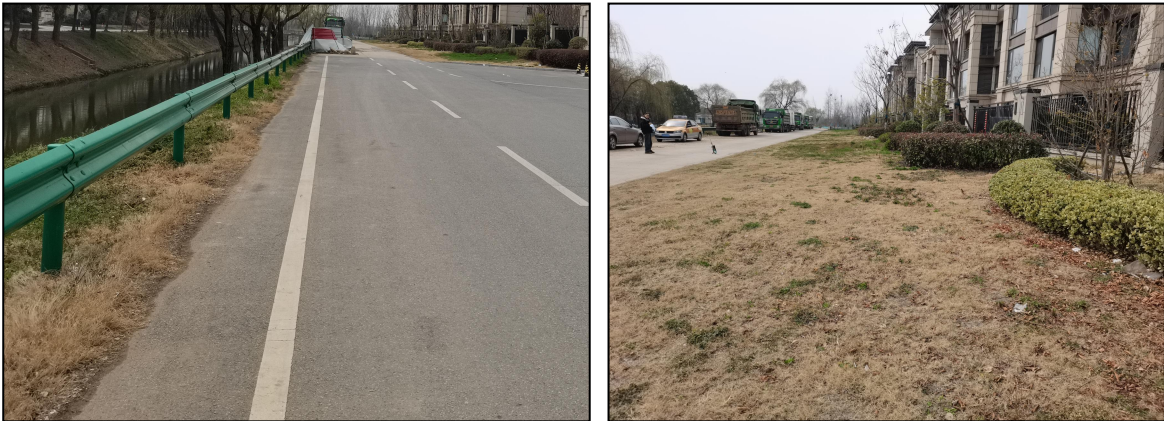
图2-5 路基、路面排水现状图
