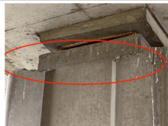
(g) 混凝土破损
