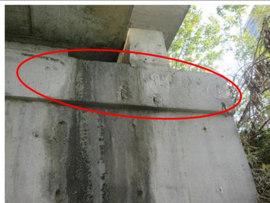
(a) 混凝土锈胀露筋
