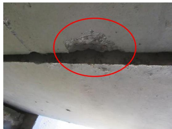
(b) 梁底混凝土破损
