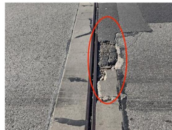
(i) 锚固区混凝土破损露筋
