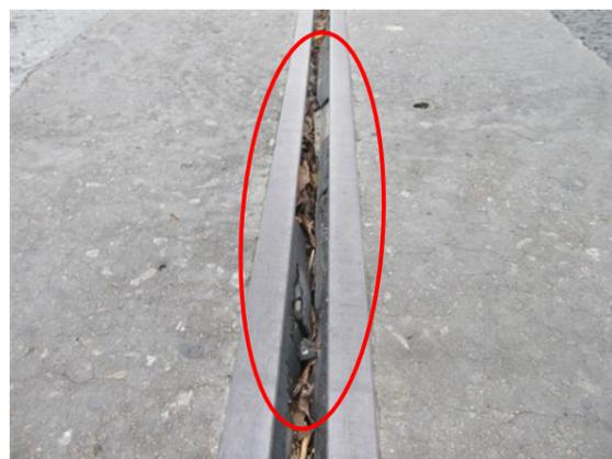
(e) 伸缩缝橡胶条破损
