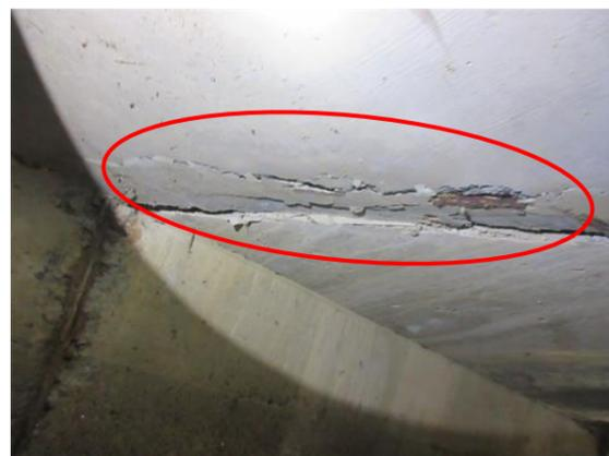
(a) 混凝土锈胀露筋
