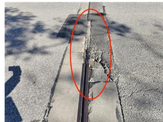
(g) 伸缩缝型钢断裂
