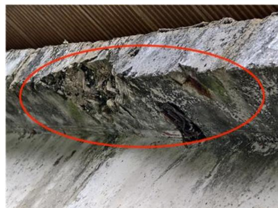
(e) 主梁破损露筋
