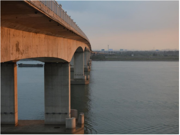
桥梁立面照（右幅）
