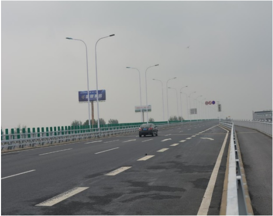
桥梁正面照（左幅）
