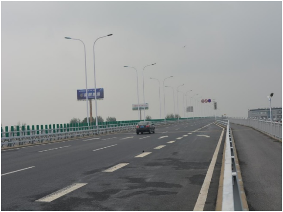
桥梁正面照（右幅）
