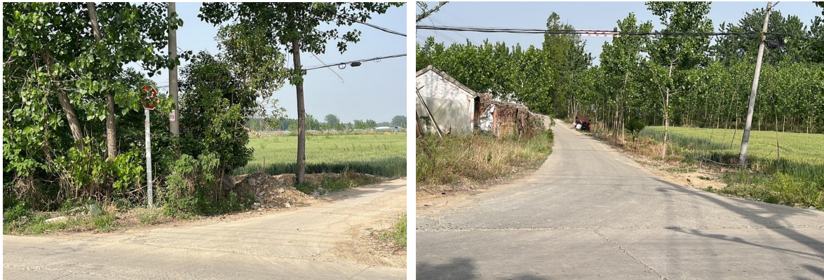
搭接道口存在道口标柱缺失
