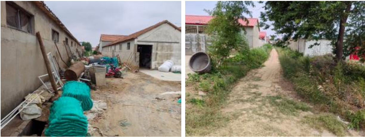
纵九路现状照片
