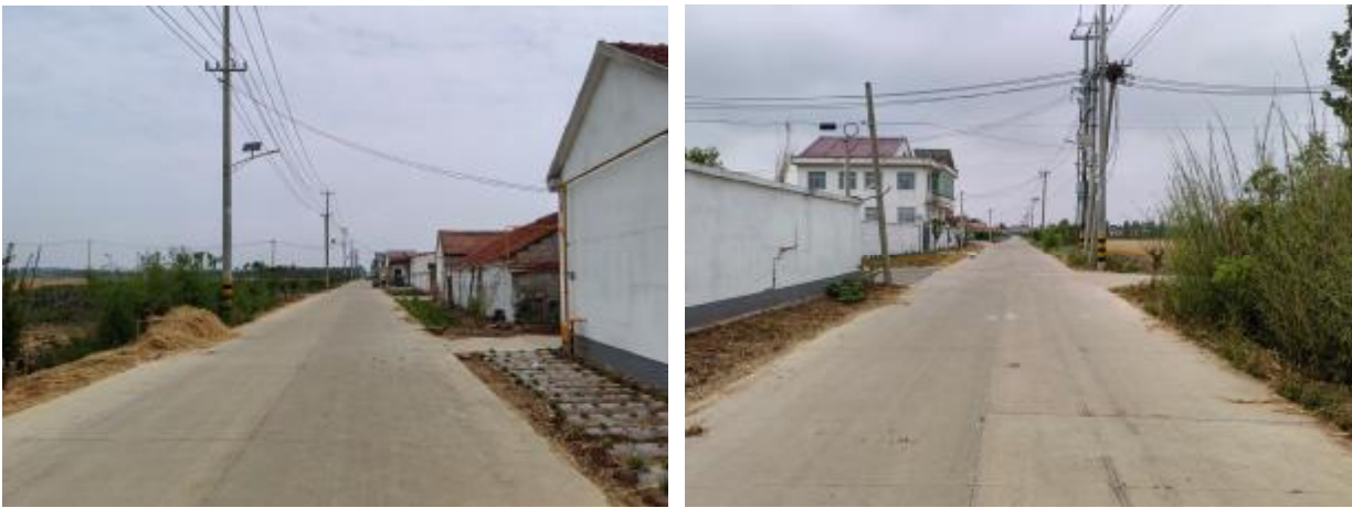
纵四路道路现状照片
