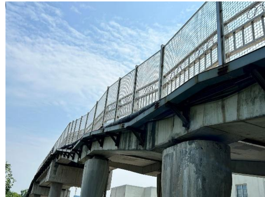
图 5.2-2 现状电缆桥架
