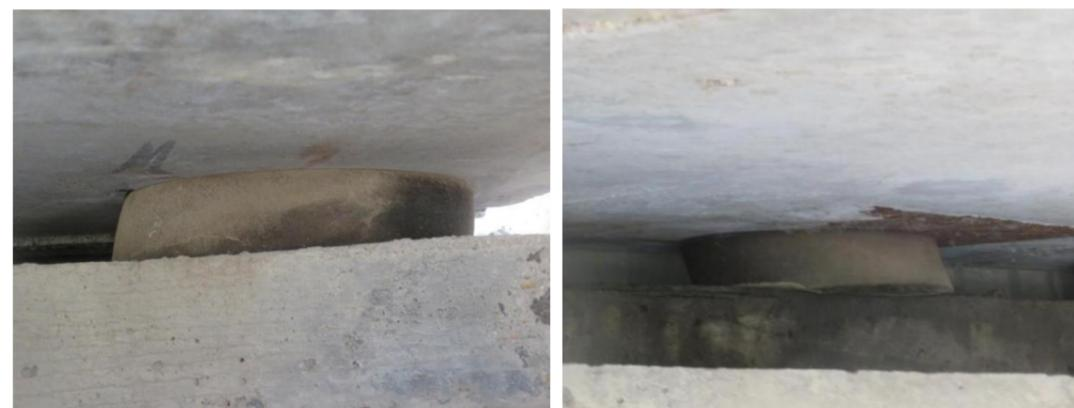
图 5.2.4 板式橡胶支座剪切变形
