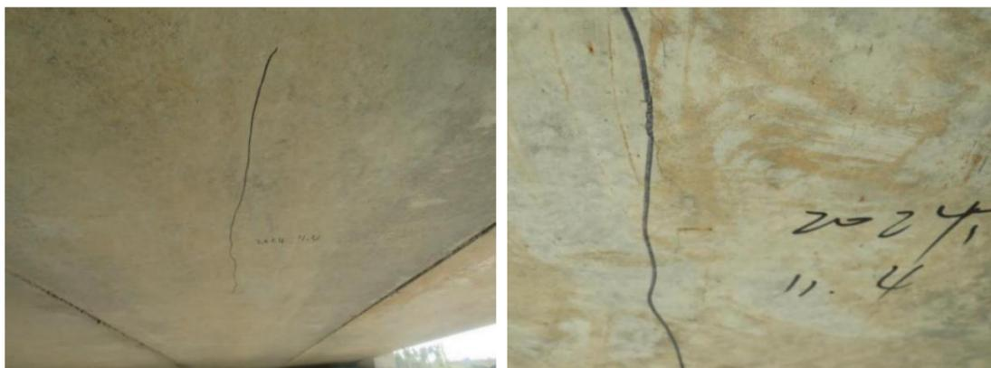
图 5.2.2 板梁板底纵向裂缝
