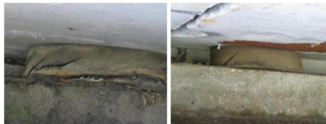
图 5.2.3 板式橡胶支座老化开裂
