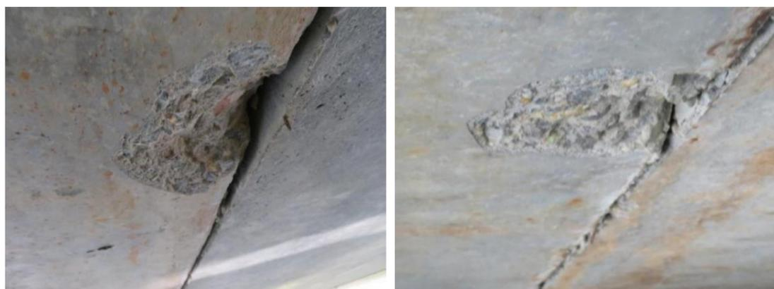
图 5.2.1 板梁混凝土剥落掉角
