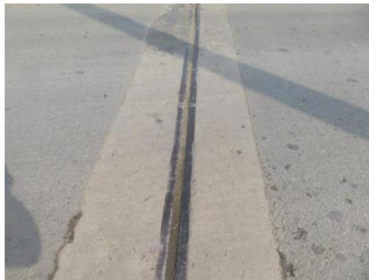
图 5.3.1 0#伸缩缝堵塞
