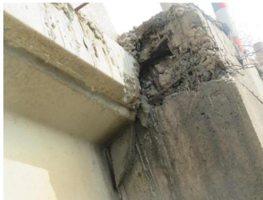
图 5.4.2 3#台右侧混凝土剥落露筋
