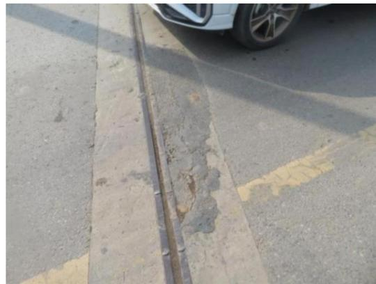
图 5.3.2 3#伸缩缝锚固区混凝土破损
