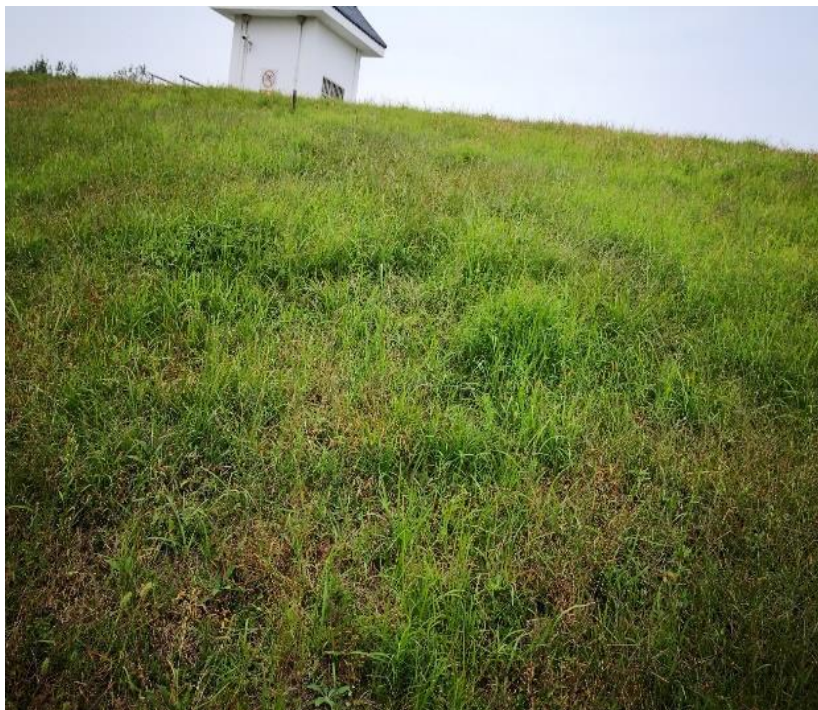
图 4.3-2 溢洪道右侧坝脚局部窖湿
