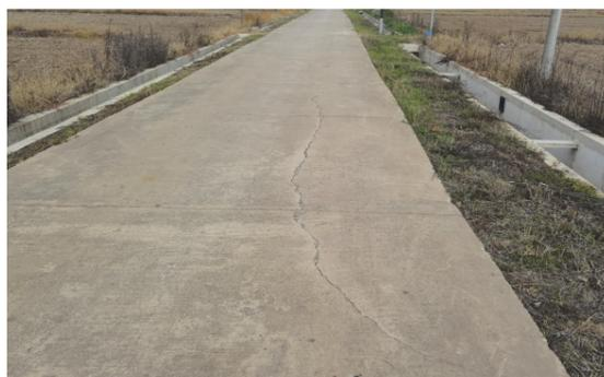
图 4-28 裂缝、角隅断裂
