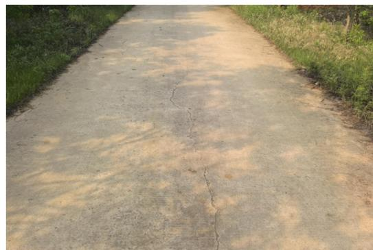
图 4-21 纵向裂缝
