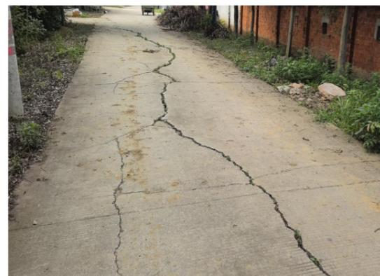
图 4-13 连续破碎板
