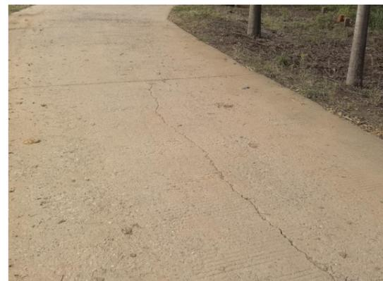
图 4-11 纵向裂缝
