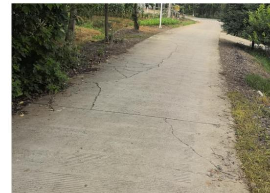
图 4-14 破碎板、角隅断裂
