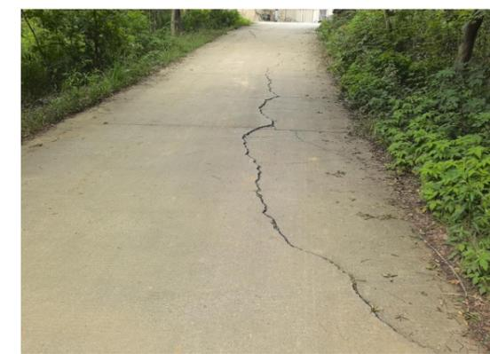
图 4-12 严重裂缝
