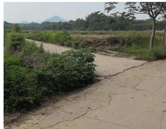
图 4-59 缺少道口警示桩、停车让行标志牌
