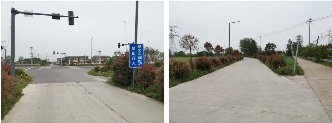
等级交叉路口缺少安全设施
