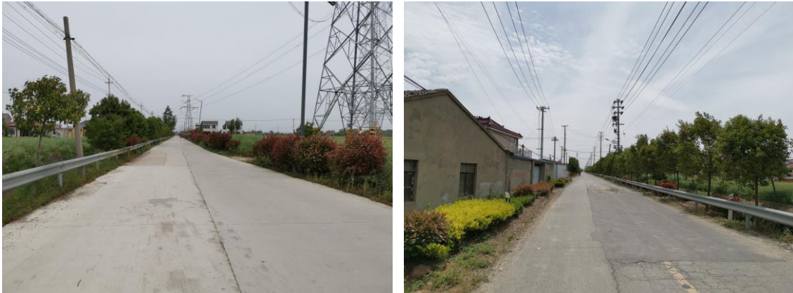
现状路面排水
