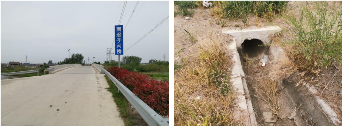
沿线现状桥梁、管涵
