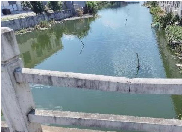
(5) 右侧护栏近 0#台构件断裂。
