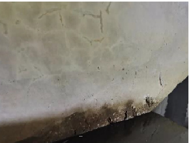
(2) 主拱腿、拱片等局部混凝土胀裂、破损、露筋锈蚀，局部连接钢板外露。
