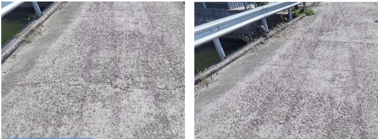
(4) 桥面铺装层骨料外露、横向裂缝。
