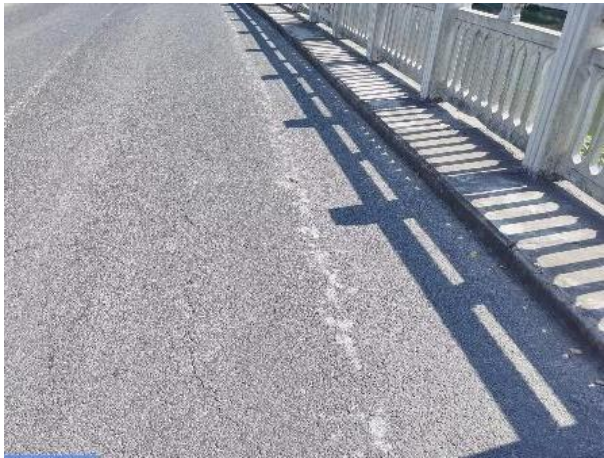
(6) 桥面铺装层局部纵、横向开裂、网裂。
