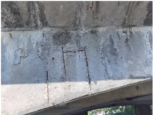
(3) 1-1#上弦杆存在露筋锈蚀。
