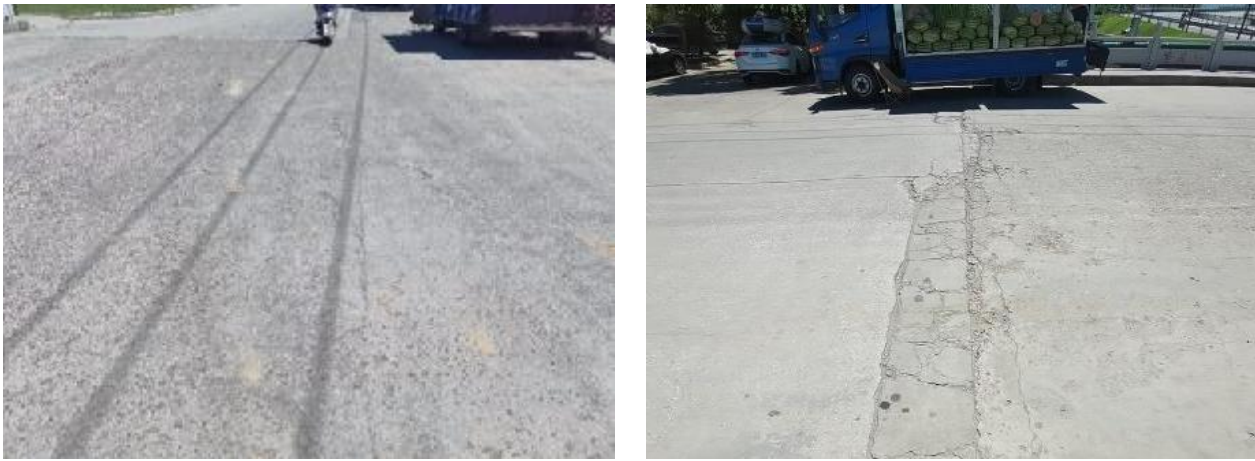
(4) 桥面铺装骨料外露，局部纵、横向开裂，混凝土碎裂。
