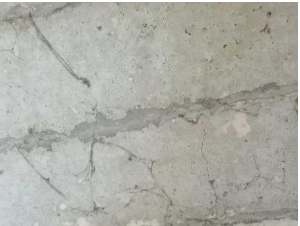
(2) 主拱腿、拱片等局部混凝土胀裂、破损、露筋锈蚀，局部连接钢板外露。
