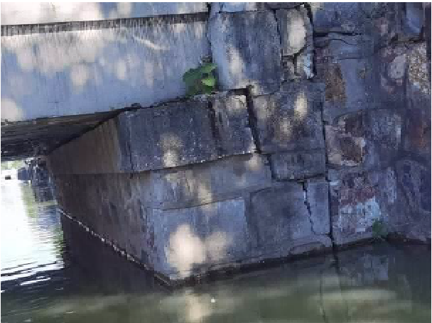
(2) 两侧桥台均存在开裂、前倾位移。
