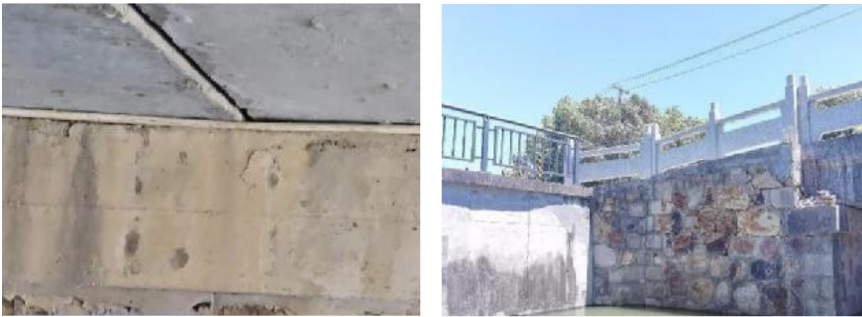
(4) 桥面铺装骨料外露，局部纵、横向开裂，混凝土碎裂。
