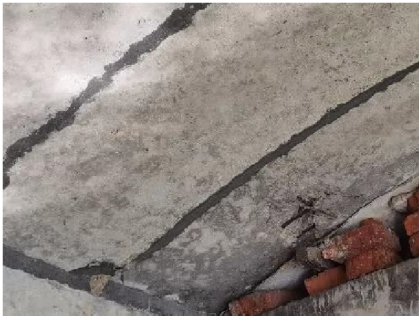
(2) 主拱腿、拱片等局部混凝土胀裂、破损、露筋锈蚀，局部连接钢板外露。
