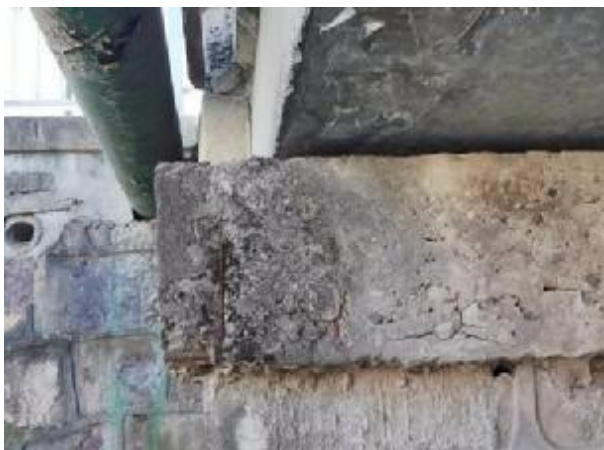
(2) 两侧桥台均存在开裂、前倾位移。
