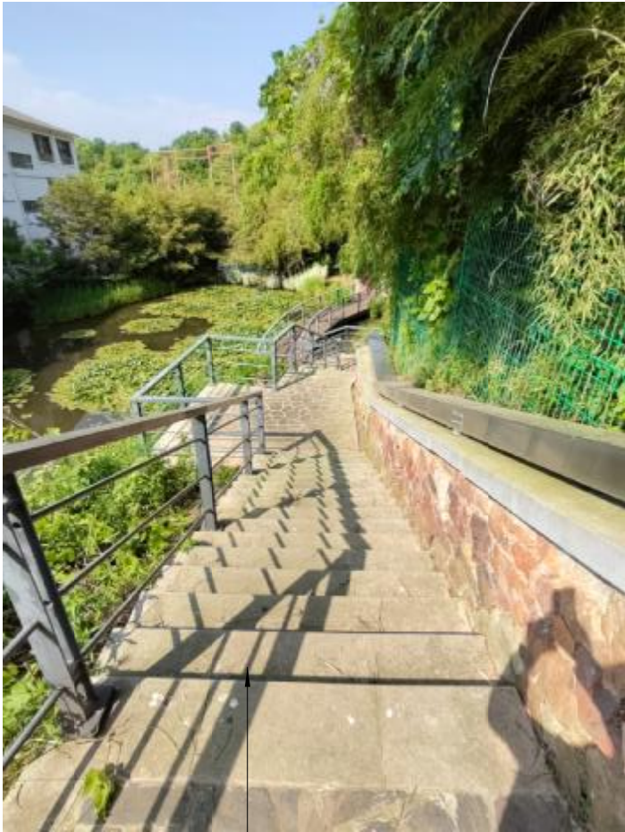
建筑后侧平台廊道石材清洗 专用石材清洗剂清洗
