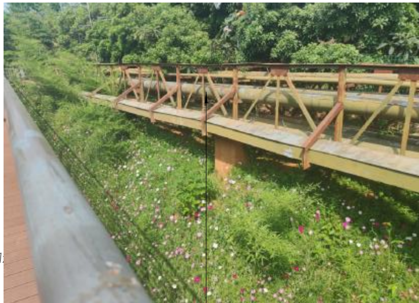
现状管道廊进行遮蔽美化处理
