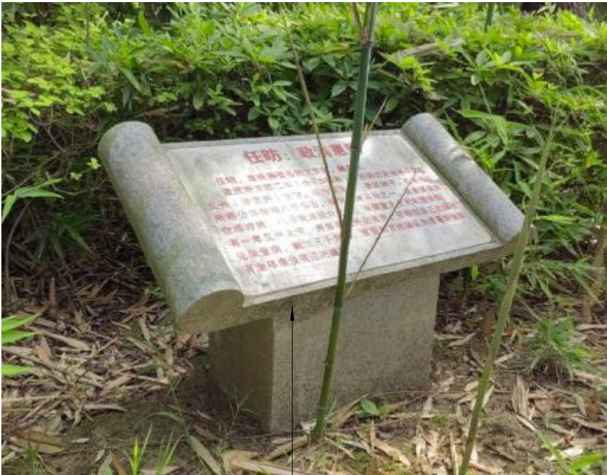
现状石材小品清洗 专用石材清洗剂清洗
