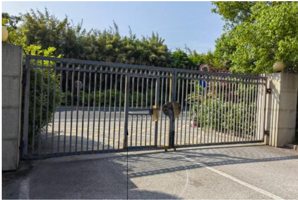
现状门氟碳漆翻新 工艺见施工设计说明
