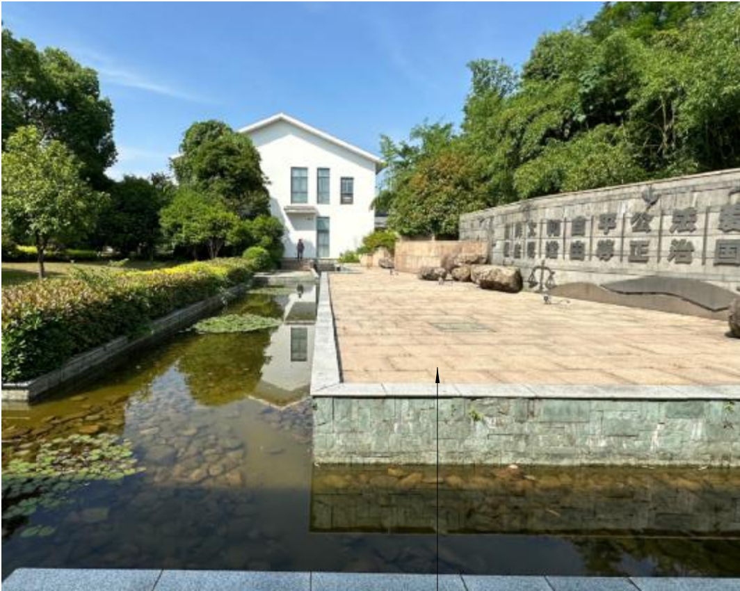
该现状铺装及墙面石材清洗 专用石材清洗剂清洗
