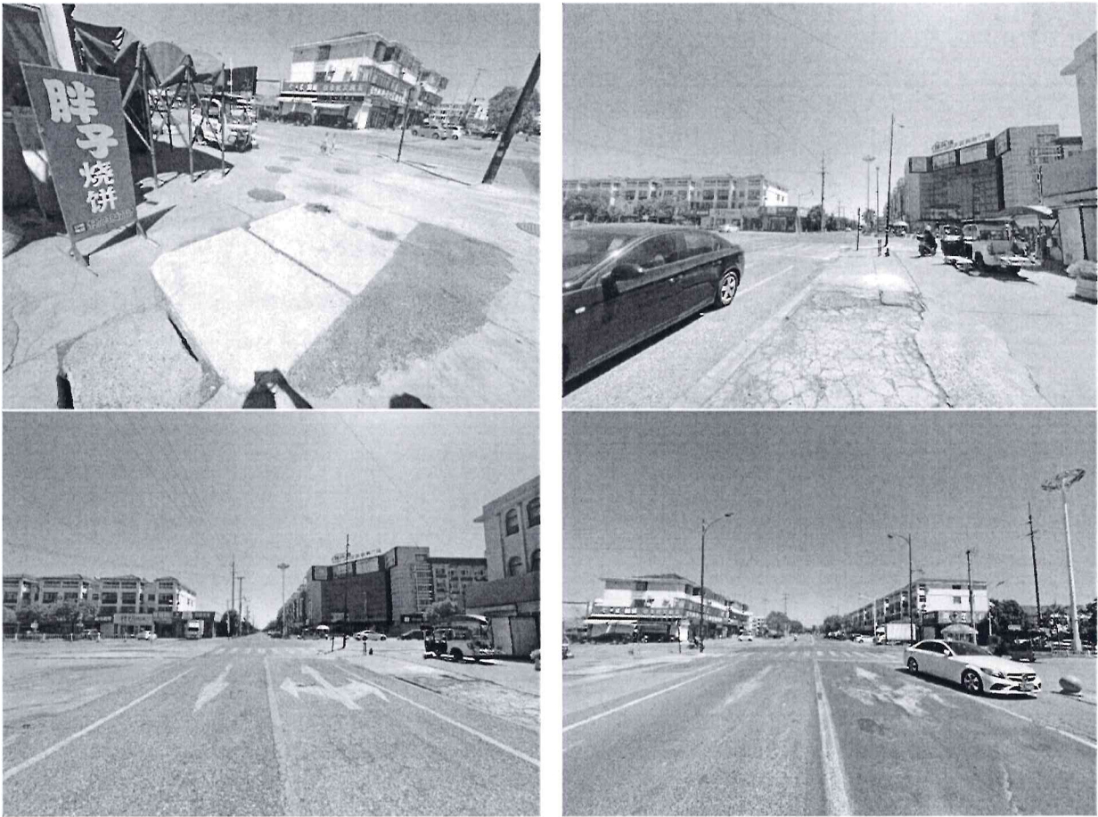
仙鹤路与正通路交叉口现状
