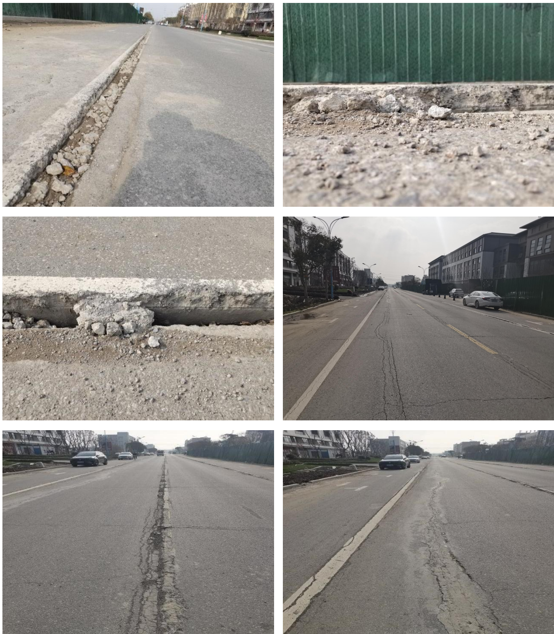
图 4 沉陷形成错台、横向位移等病害
