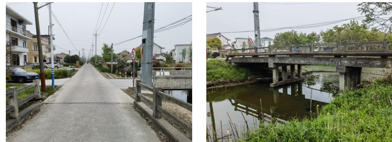
图 1-1 四甲镇志俊界桥老桥现状
